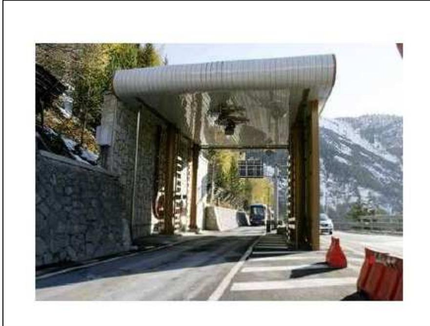
Figura 42: Esempio di portale termografico [92]
