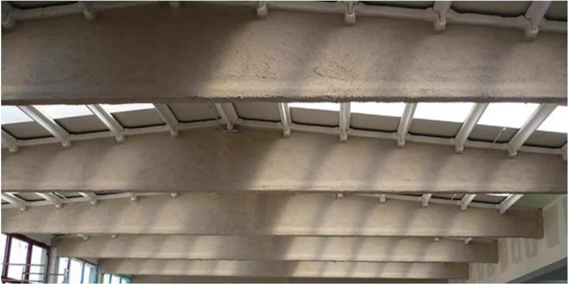
*Fig.99 §5. – Protezione antincendio travi in c.a. prefabbricato con intonaco ignifugo*
