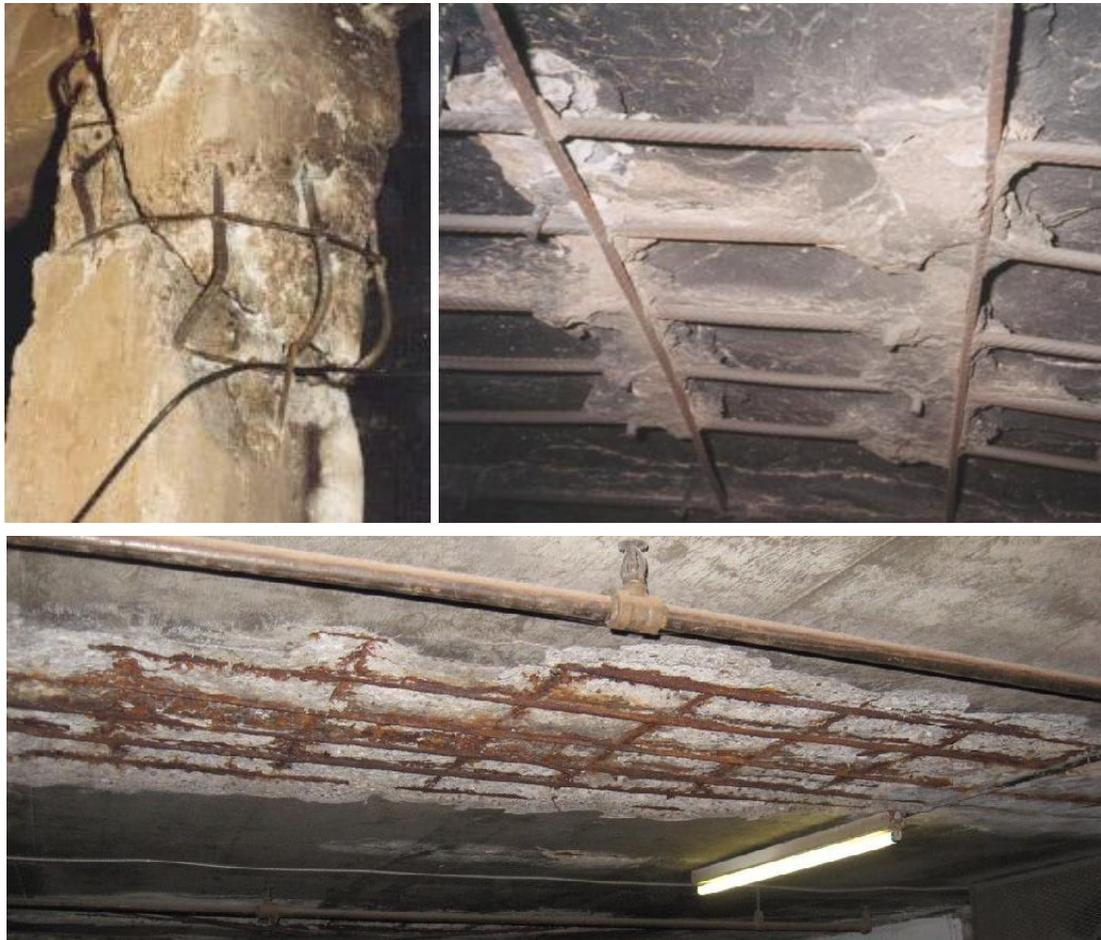
*Fig.13 §2. – Esempi di riduzione della sezione resistente per effetto spalling*
