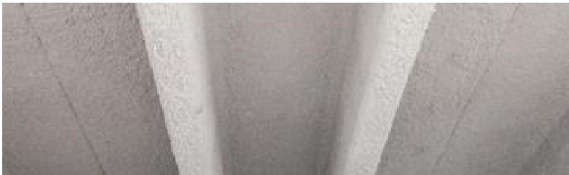
Fig.98 §5. – Protezione antincendio tegoli in c.a. prefabbricato con intonaco ignifugo
