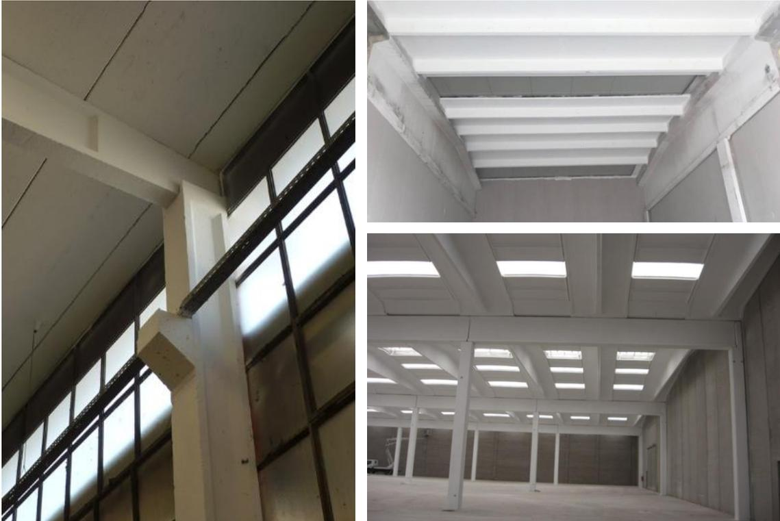
*Fig.100 §5. – Protezione antincendio strutture prefabbricate con vernice intumescente*
