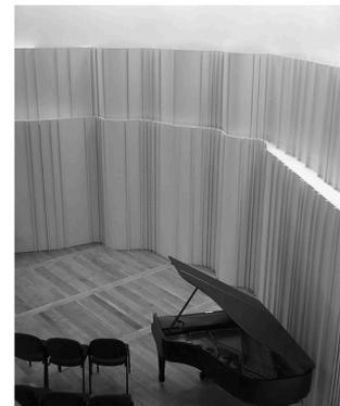
Figura 24 – A sinistra: riflessione di un arco concavo confrontato con un diffusore curvo ottimizzato a 3 KHz, linea continua: arco concavo e linea tratteggiata: diffusore curvo ottimizzato. A destra: superficie curva ottimizzata (Waveform) nella Edwina Palmer Hall [1].
