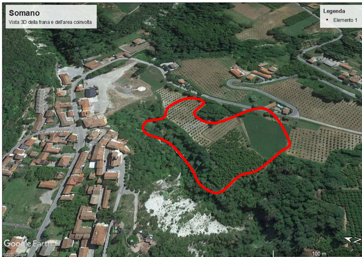
Figura 41: Vista 3D del luogo oggetto del caso studio con individuazione della frana. Fonte Google Earth
