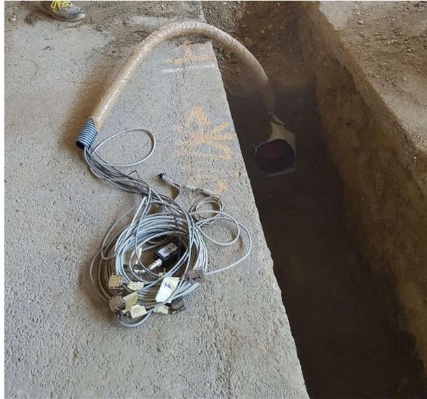
*Figura 11. Fase di rintombamento del tubo. Sulla sinistra si può notare una parte strumentazione utile alla lettura dei sensori installati all'interno della tubazione.*
