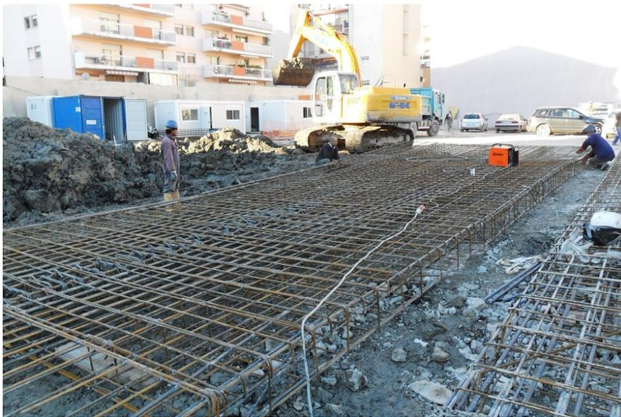
*Figura 41 Preparazione delle gabbie di armatura (www.scstn.it)*
