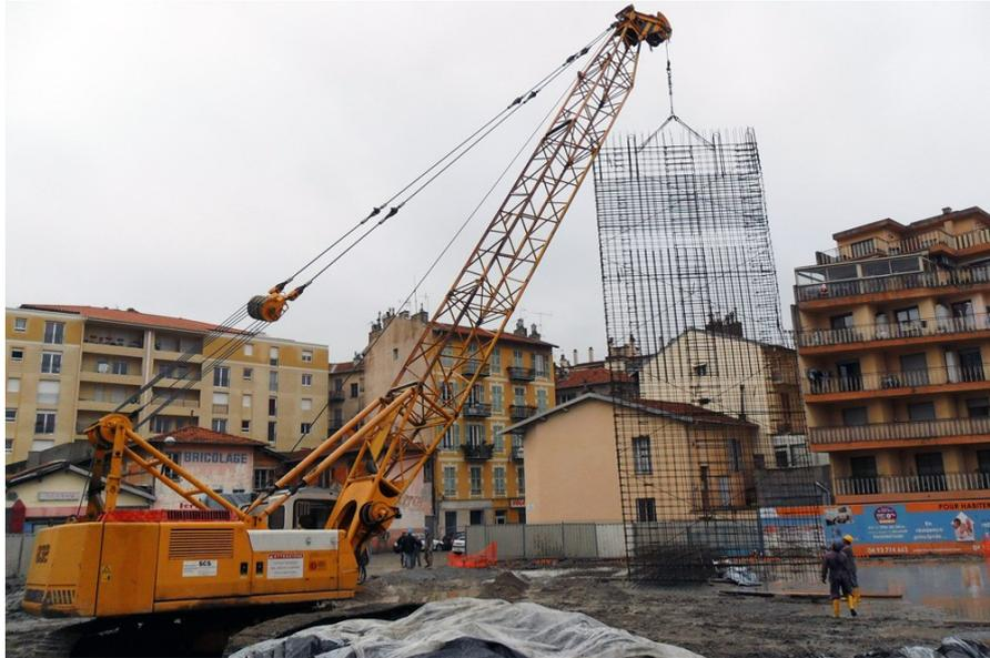
Figura 38 Operazioni di posizionamento di una gabbia di armatura in acciaio per diaframma. Si notino i ferri disposti diagonalmente, il cui scopo è impedire eccessive deformazioni della gabbia durante le operazioni di spostamento mediante gru (www.scstn.it)
