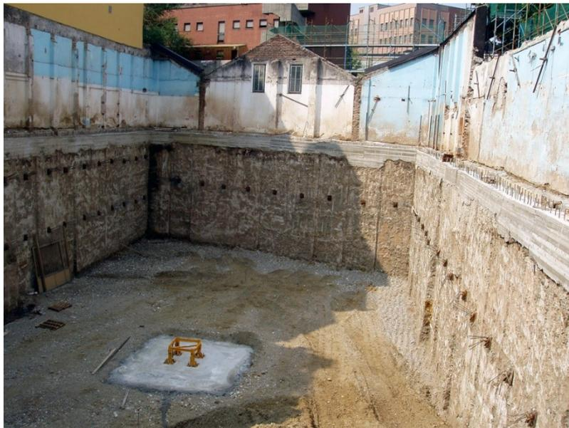
*Figura 23 Paratie in calcestruzzo armato con tiranti in acciaio (www.scstn.it)*
