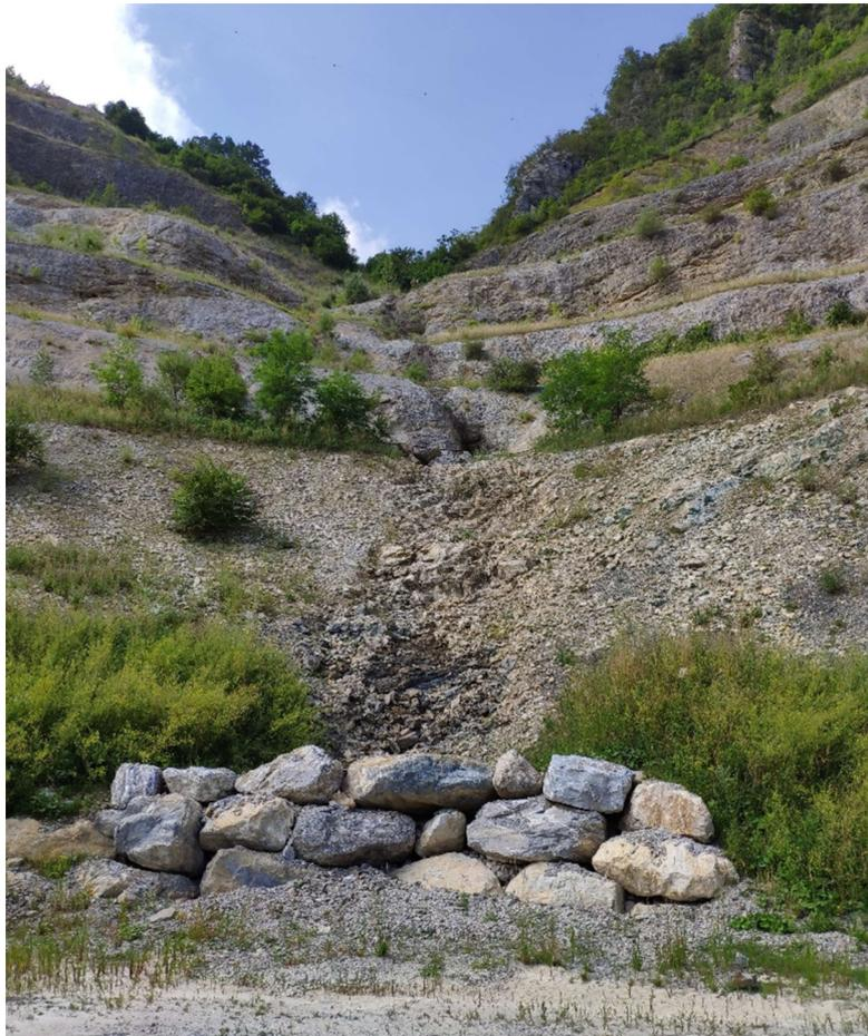
*Figura 37 - Opere di sistemazione idraulica del Rio Monfranco. È in atto la rivegetazione delle sponde laterali.*
