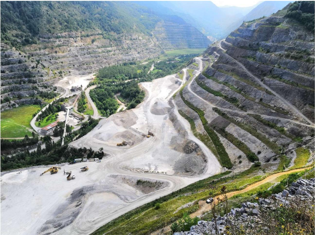
*Figura 22 - Vista del piazzale di cava dai gradoni di Monfranco. Sulla destra sono visibili i gradoni parzialmente recuperati del cantiere Tabanot. In centro a sinistra l'officina e gli impianti di partenza del nastro e sullo sfondo i gradoni esauriti del fronte in sponda orografica destra.*
