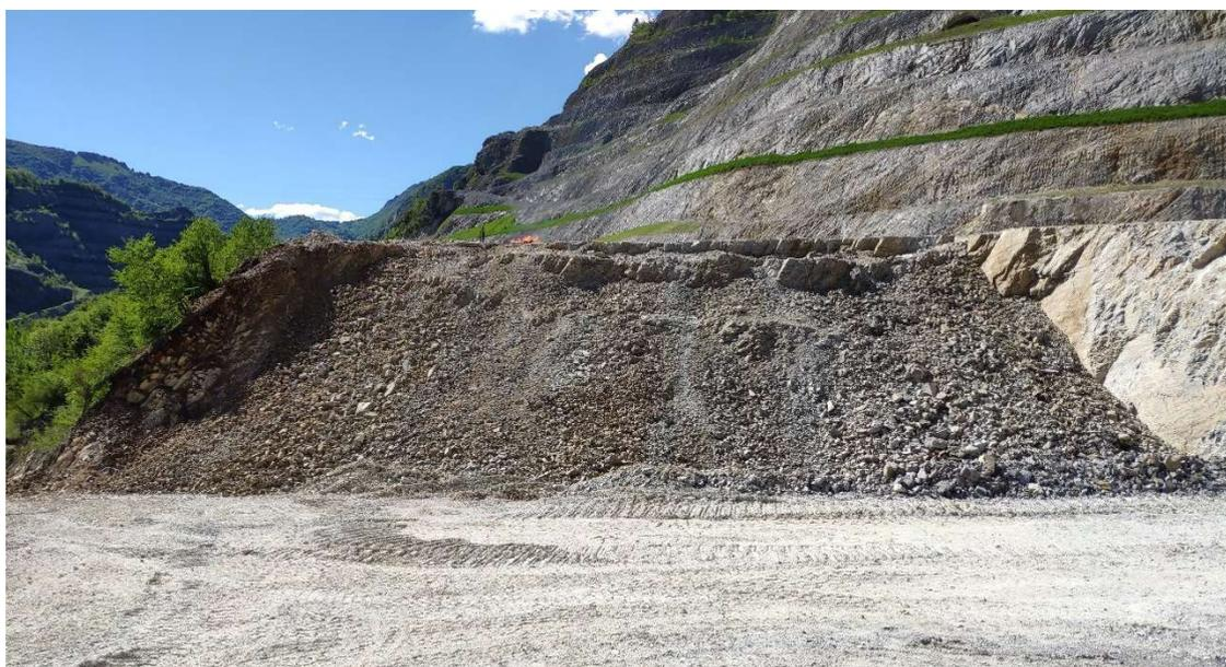
Figura 29 - Volume di roccia frammentata in seguito al brillamento.
