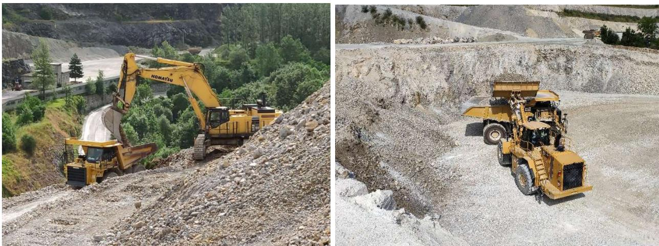
Figura 30 – Escavatore, pala caricatrice e dumper impiegati nella fase di sgombero.
