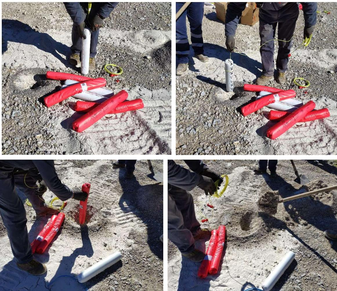
*Figura 25 - Fasi del caricamento: inserimento del detonatore nell'emulsione; introduzione della cartuccia di EXEM 100 in foro; introduzione dell'ANFO in foro; divisione delle cariche con borraggio intermedio.*
