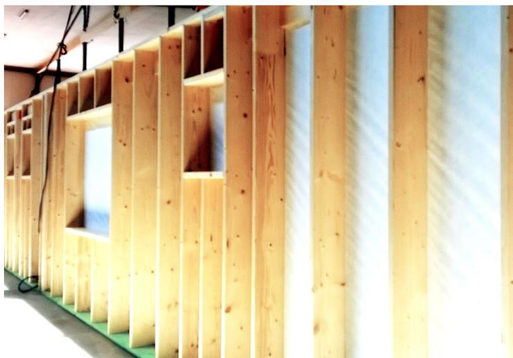
(b) Parete intelaiata in fase di montaggio in attesa di essere terminata per il trasporto in cantiere. Le pareti pre-montate arrivano in cantiere dove vengono unite al solaio controterra e completate con i serramenti: i muri interi di edifici vengono raggruppati dentro a dei container e spediti sul sito, anche in cantieri esteri.
