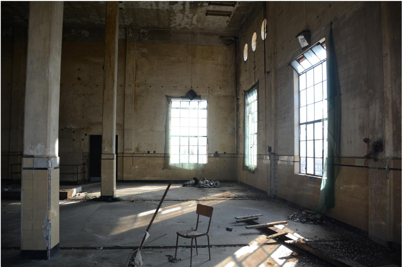
Il magazzino principale del piano secondo rileva la presenza di soffitti alti, della luce naturale che filtra dalle grandi finestre e delle aperture circolari che ospitavano gli isolatori per il passaggio dei cavi. (Scatto dell'autrice, 2019)
