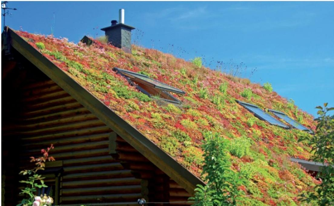
Figura 36 - Esempio di tetto verde.
