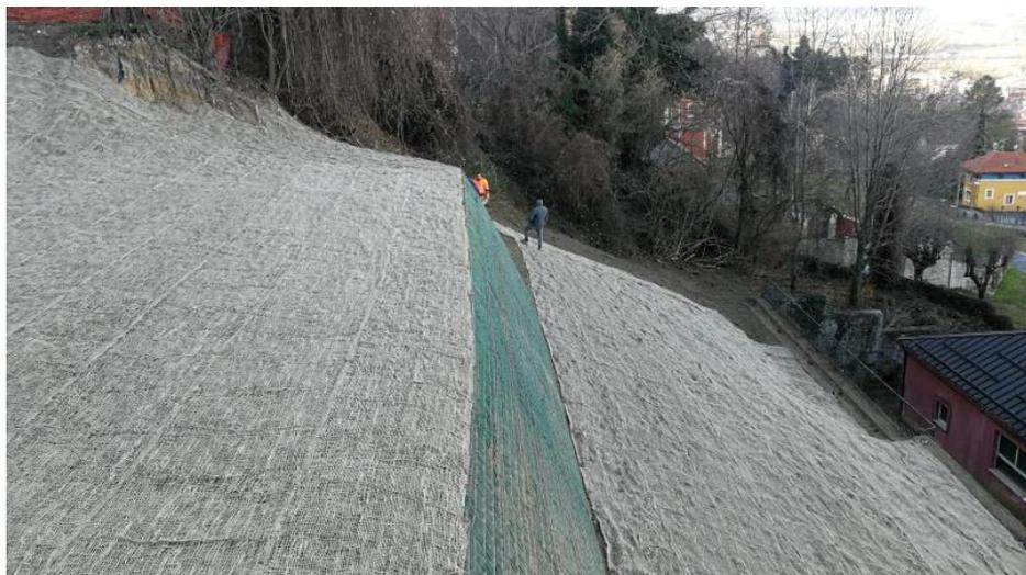
**Fig.7.10 – Intervento riprofilatura eseguito**
