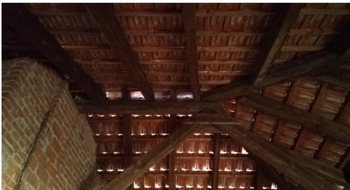
**Figura 2.0.9 Particolare della copertura in legno**
