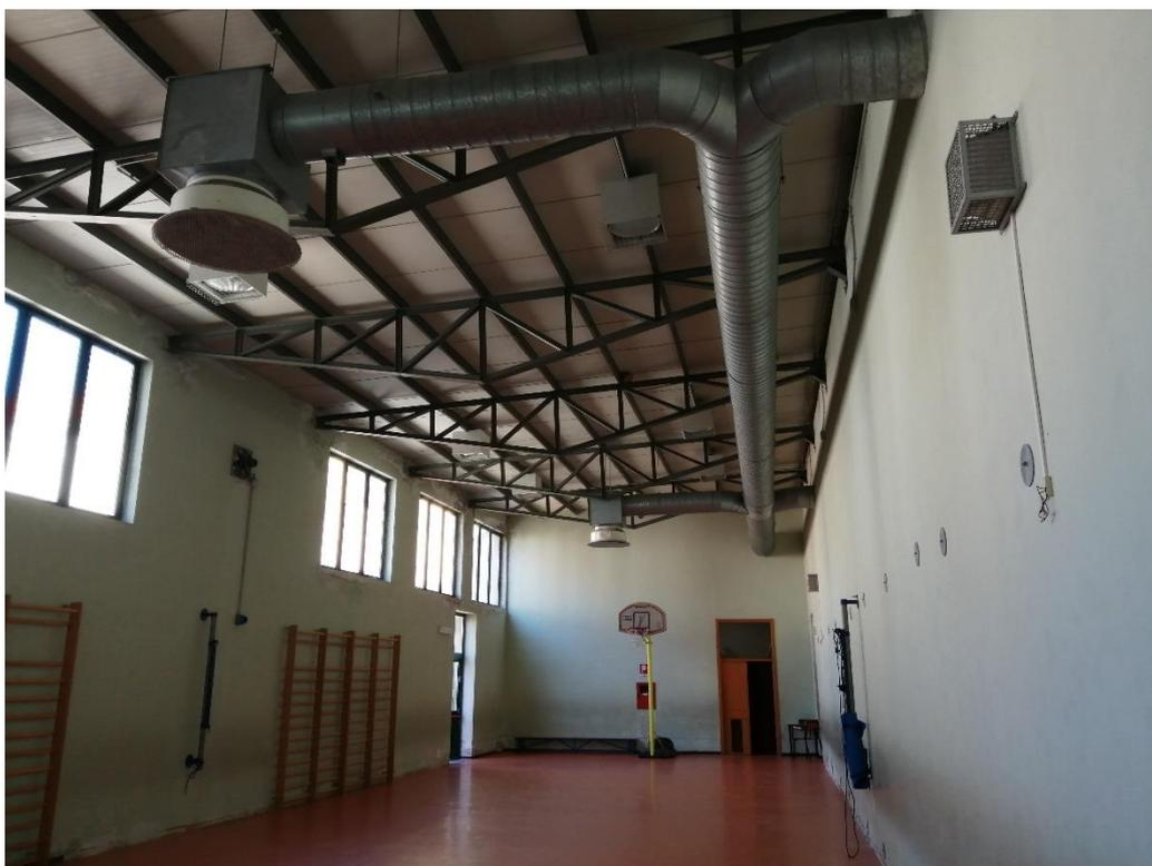
**Figura 2.0.7 Palestra della scuola "De Amicis" con copertura in acciaio**
