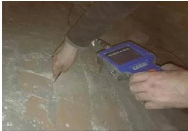
**Figura 2.20 Particolare dell'esecuzione di un'endoscopia attraverso una volta in muratura**
