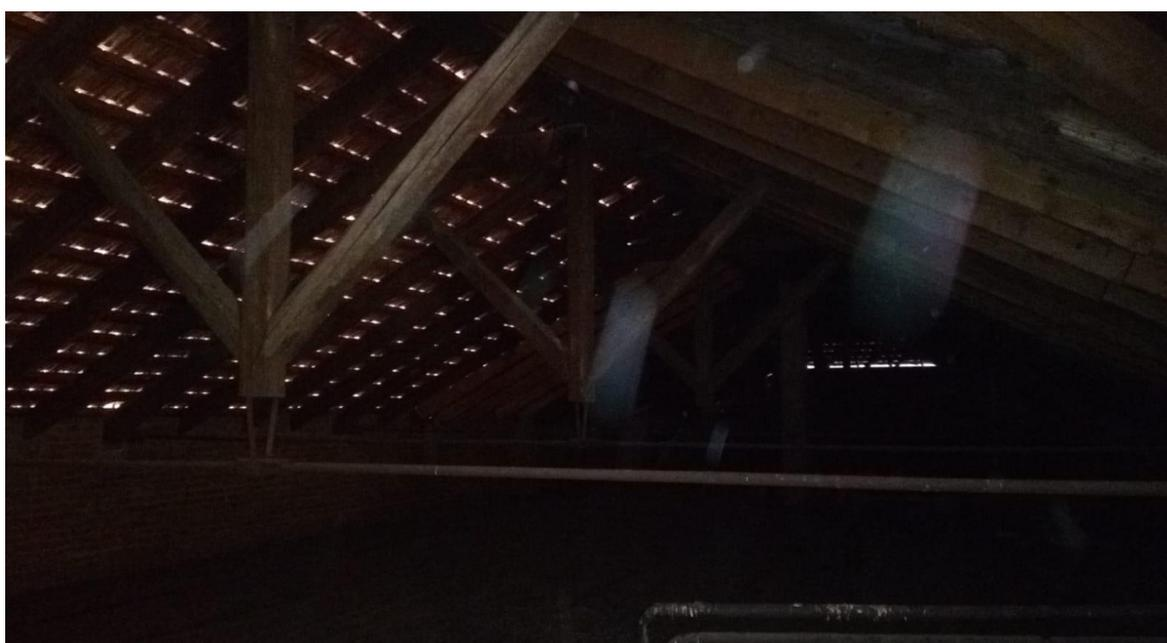
**Figura 2.0.10 Particolare delle capriate in legno**
