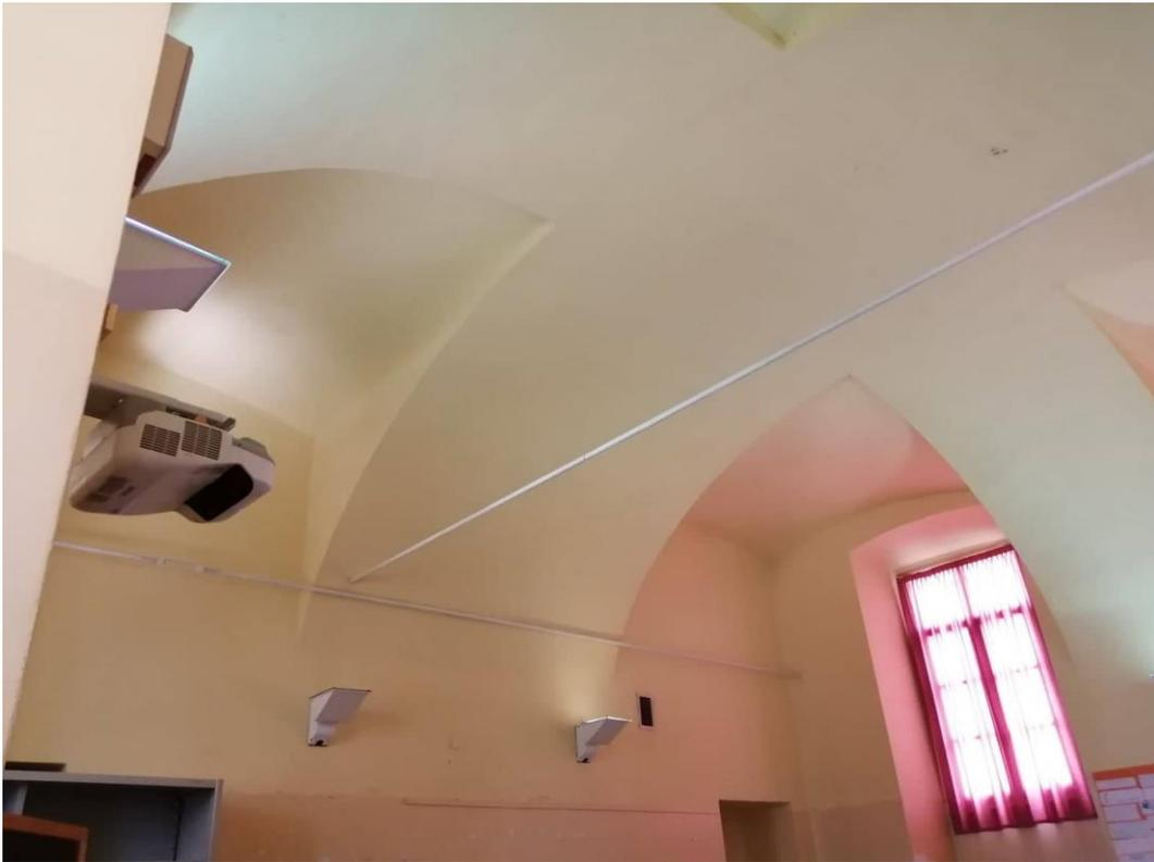
**Figura 2.0.11 Particolare di una volta a padiglione con catena di rinforzo**
