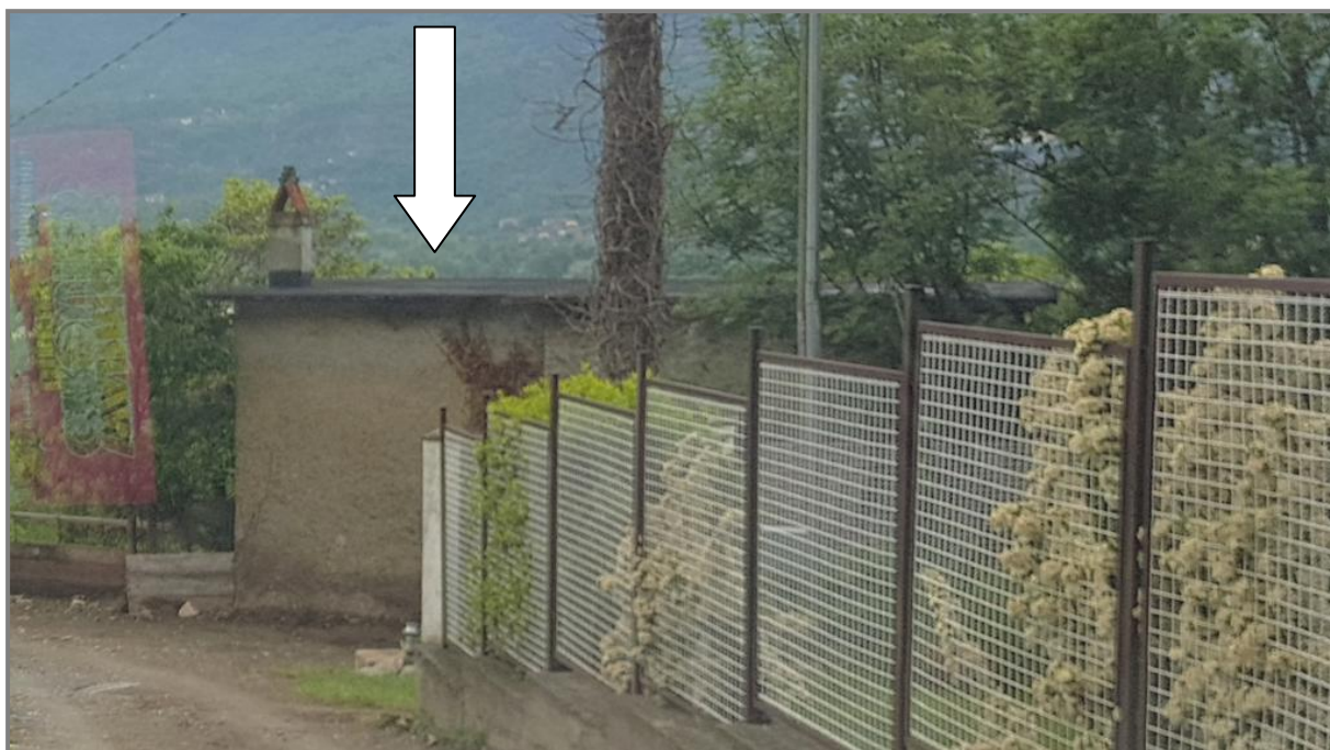
Figura 110: Catastale 1139 edificio distrutto dalla colata – vista lato nord (foto scattata il 21 maggio 2018 da Santo La Ferlita - Studio Rosso – Torino)
