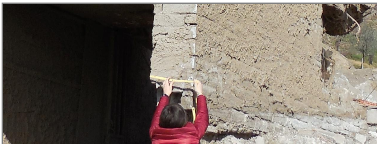
Figura 49: rilievo in campo delle altezze del deposito e dei danni (1) – Particella 377
