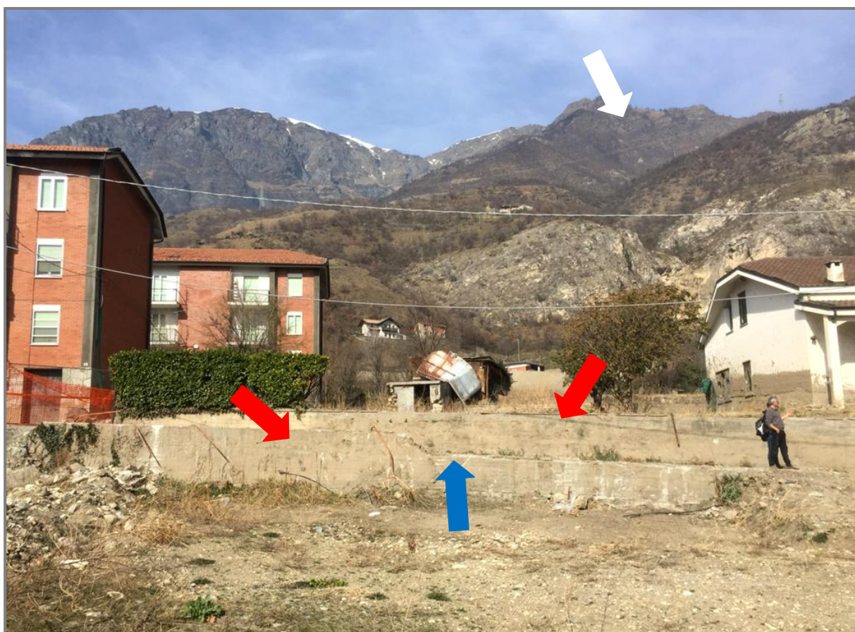
Figura 92: fotografia dell'area interessata dall'evento di debris-flow a febbraio 2019 (otto mesi dopo l'evento). In evidenza i muretti di recinzione trasversali alla direzione principale di deflusso che hanno contribuito ad arrestare l'avanzata della colata (freccie rosse). Parte di muretto danneggiato (freccia blu). Il bacino idrografico Comba delle Foglie (freccia bianca). A sinistra il catastale 935. A destra i catastali 713 e 1008.
