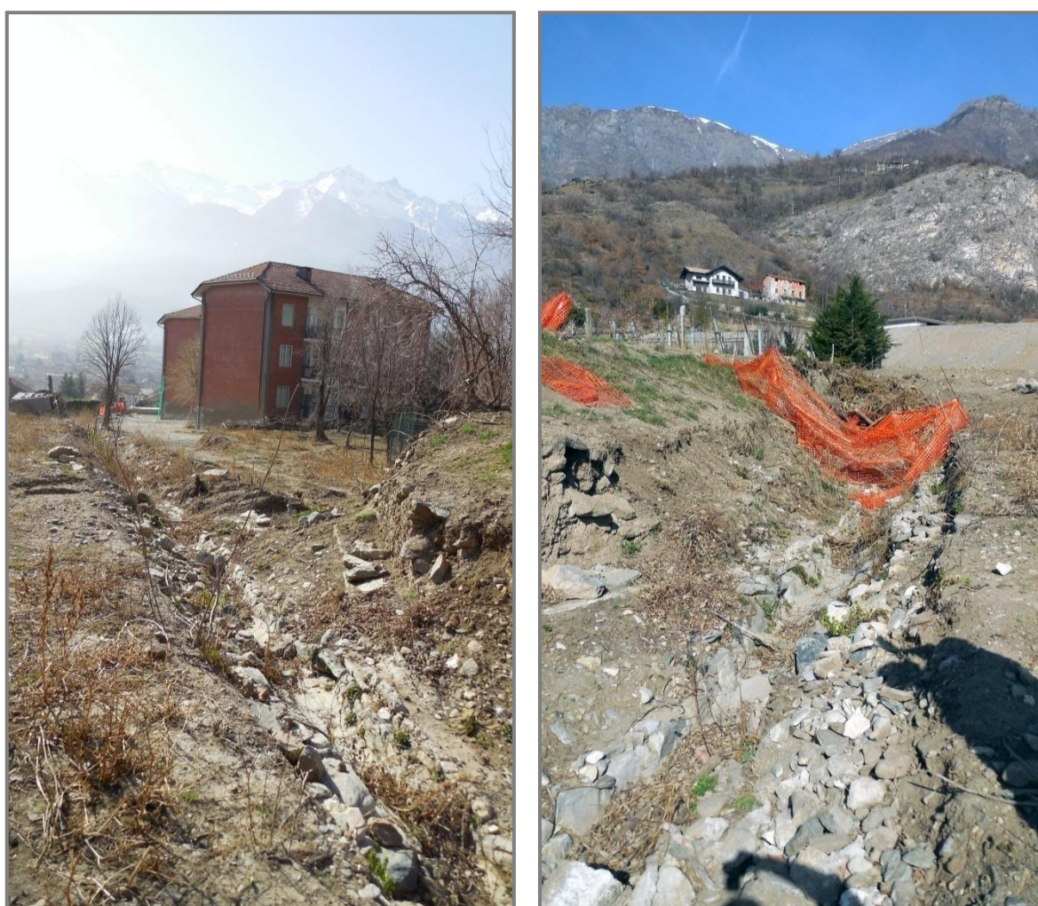
Figura 75: sopralluogo del 28 febbraio 2019; in evidenza la vecchia bialéra riemersa dopo il passaggio della massa fluida, che ne ha favorito il deflusso in direzione nord-sud.
