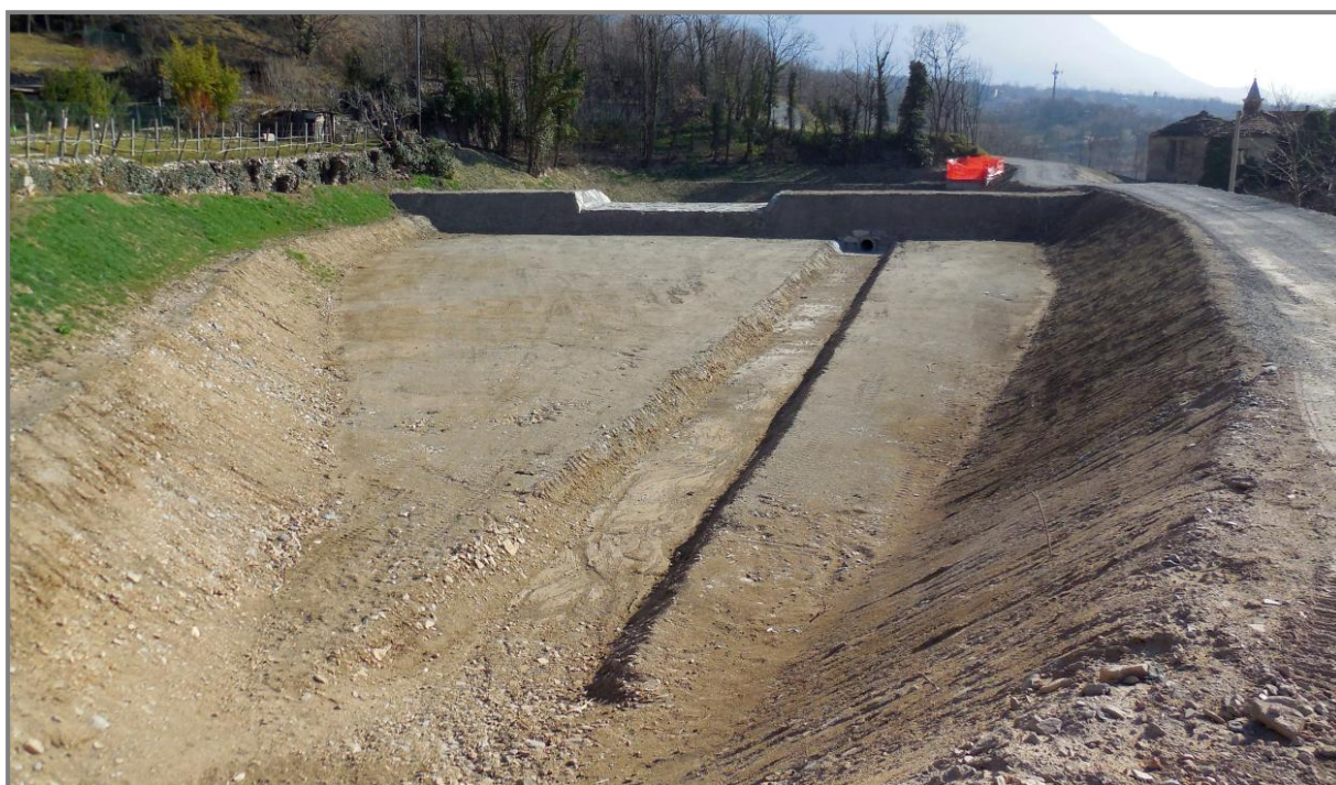
Figura 123: vasca di laminazione a monte (foto scattata il 28/02/2019)
