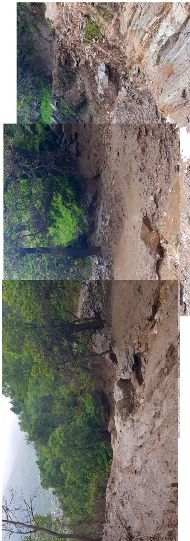
Figura 102: condensatore di sedimenti temporaneo lungo l'asta principale. Composizione fotografica (foto fornite da Santo La Ferlita studio Rosso – TO)
