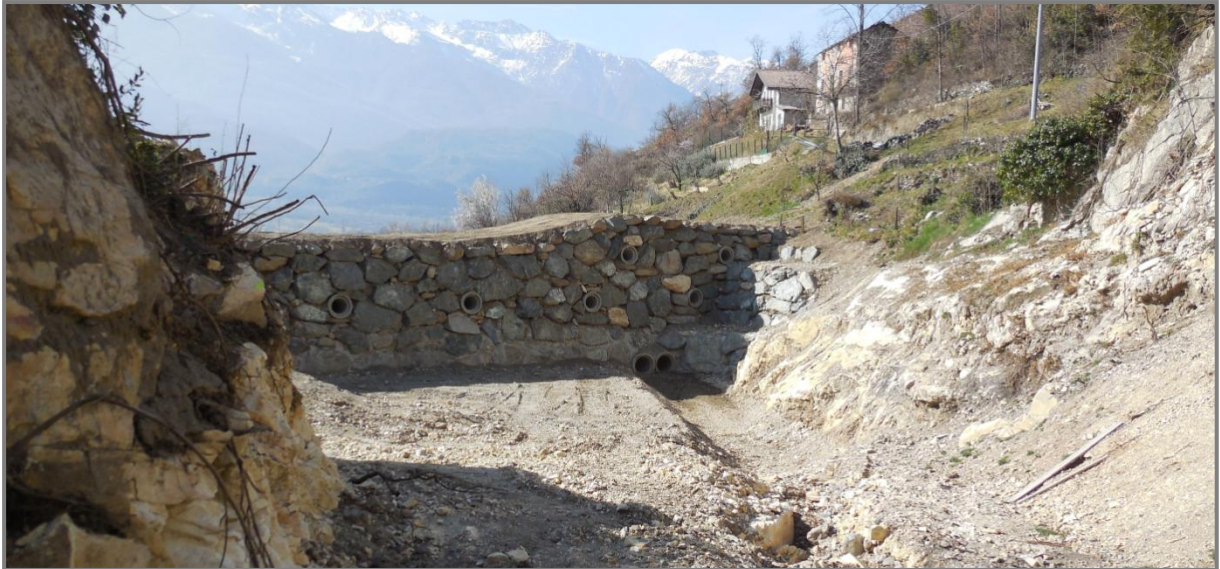
Figura 120: bacino di accumulo in apice di conoide da 7000 m 3 . Vista verso valle. (foto scattata il 28/02/2019)
