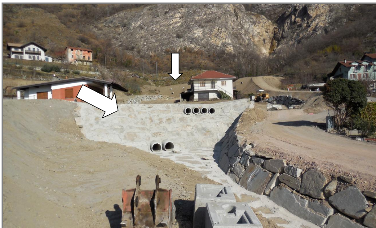
Figura 122: canale di scarico del bacino di accumulo supplementare. Vista verso monte. In evidenza i rilevati dei due bacini di accumulo (foto scattata il 28/02/2019)
