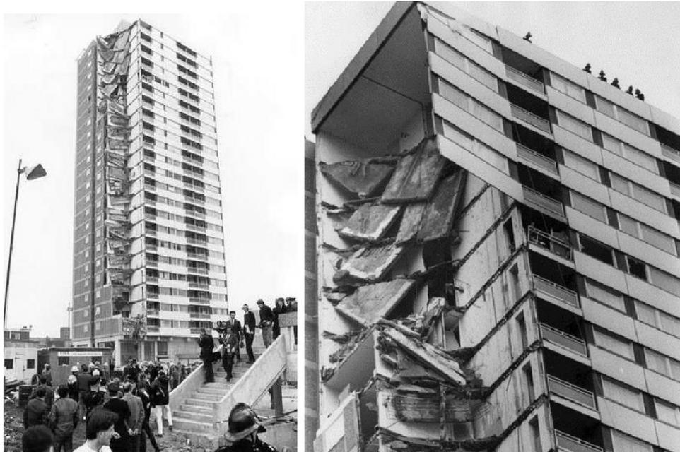
Figura 1: Crollo dell'intero angolo della Ronan Point Tower ([www.researchgate.net](http://www.researchgate.net))
