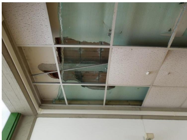
*Figura 12 - Dettaglio solaio in laterocemento e rete antisfondellamento*
