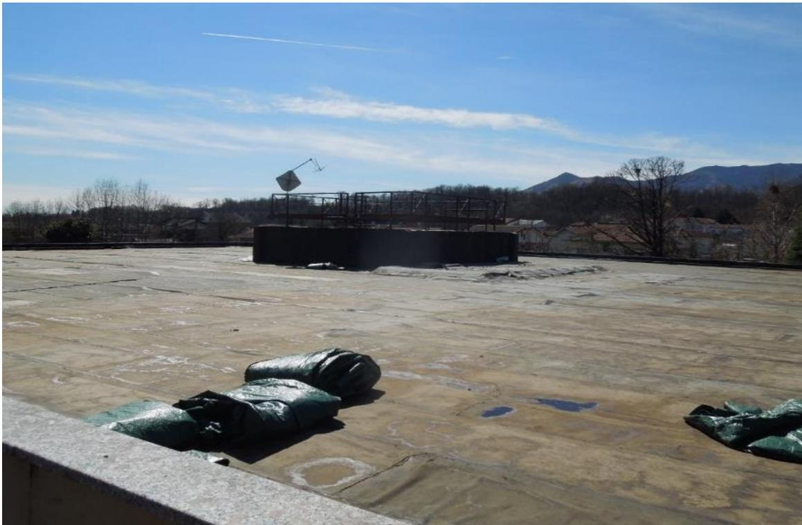
*Figura 10 - Solaio coperto con guaina in seguito al sollevamento della copertura*
