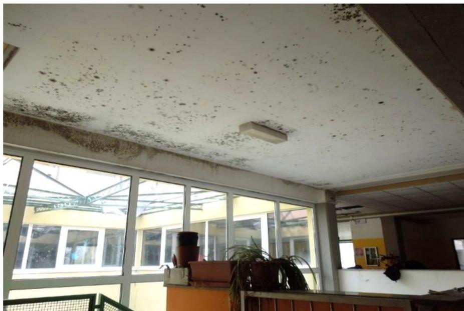
*Figura 11 - Dettaglio umidità presente sul controsoffitto nella zona delle scale verso il seminterrato*
