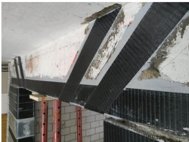
*Figura 54 - Consolidamento di una trave a flessione e a taglio mediante l'utilizzo di un tessuto CFRP*
