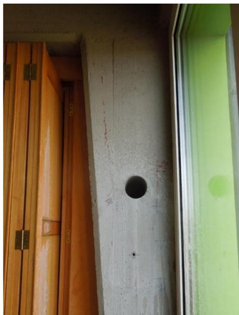
*Figura 29 - Carotatura pilastro*
