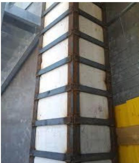
*Figura 53 - Consolidamento di un pilastro mediante incamiciatura in acciaio*
