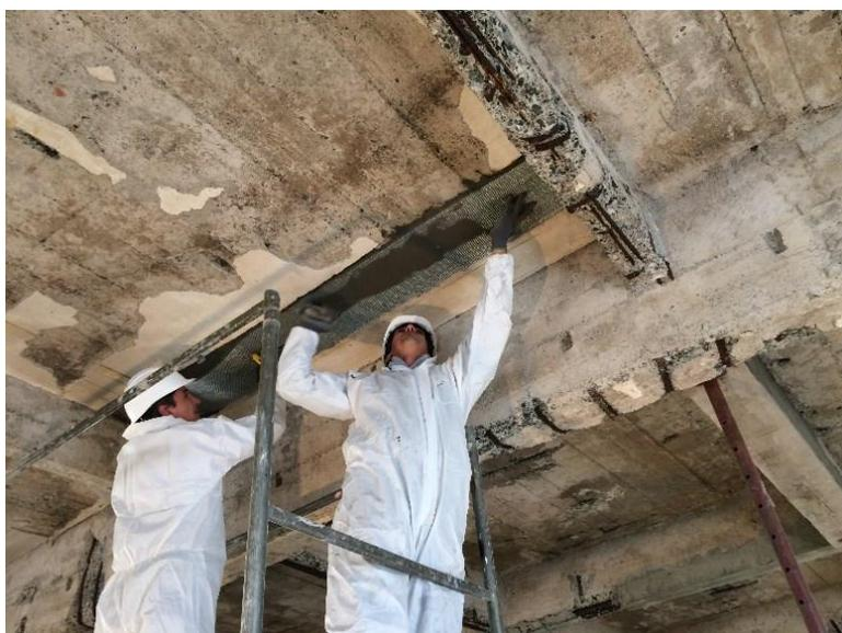
*Figura 55 - Consolidamento di una trave mediante l'utilizzo di un tessuto FRCM*
