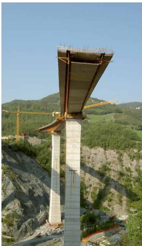
*Fig. 3. 3. Impalcato fase costruzione viadotto Roccaprebalza (<http://www.spicsrl.it>)*
