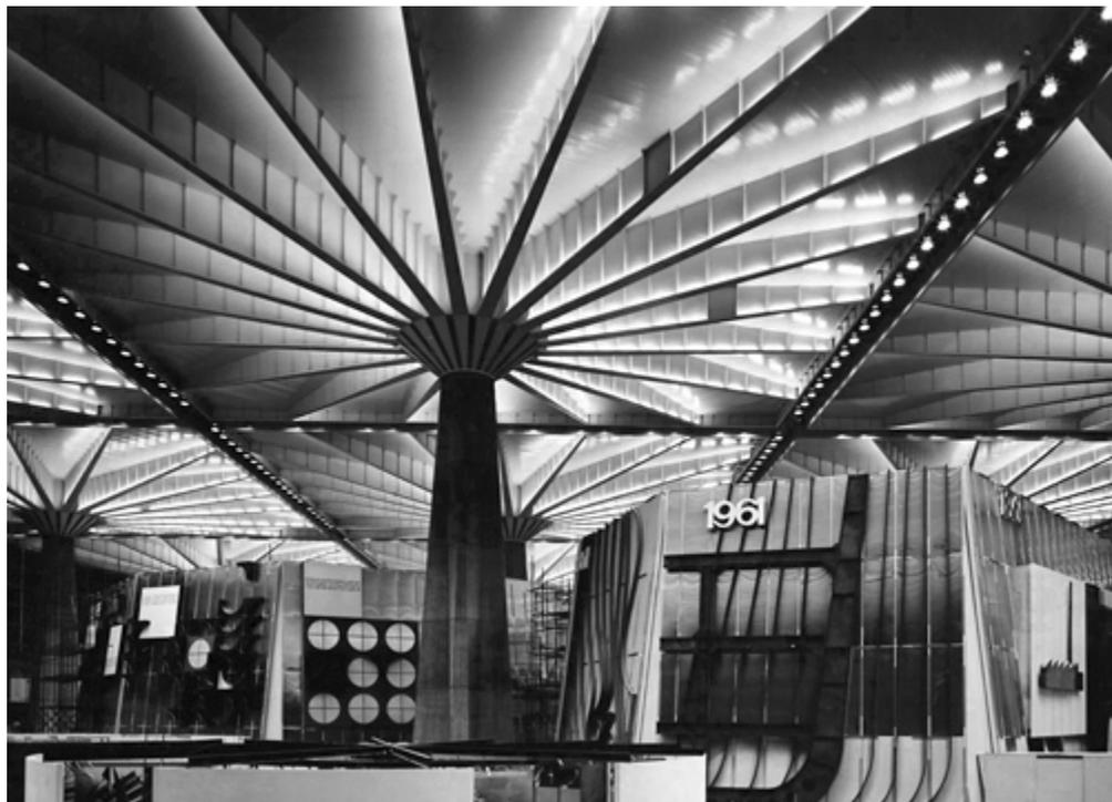
ultimato un determinato numero di essi, da poter gettare il solaio perimetrale e collocare le vetrate. La soluzione adottata fu la divisione dello spazio di copertura in un determinato numero di solai autoportanti ed eseguibili autonomamente, sorretti da enormi pilastri a forma di fungo, ottenendo così un grandioso risultato.
