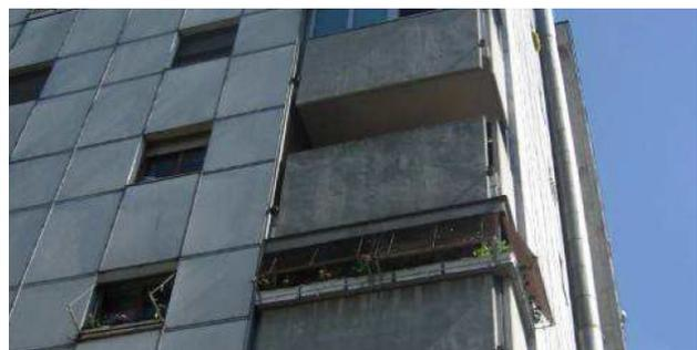
Preesistente rivestimento degradato in pannelli in fibrocemento
