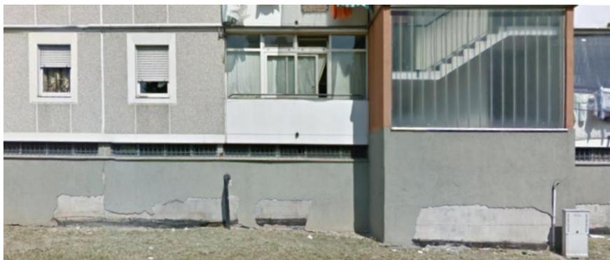
Figura 6.11 Fenomeni di distacco dell'intonaco di facciata
