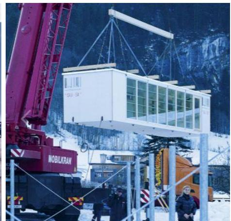
Figure 2.29 Montaggio in fabbrica, trasporto ed assemblaggio. Fonte: <https://www.kaufmannzimmerei.at/projekt/su-si-k-reuthe>
