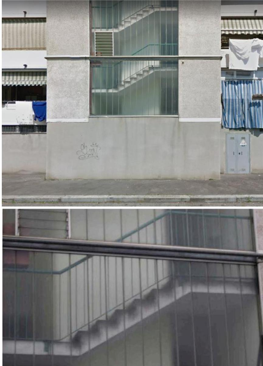
Figura 6.10 Presenza di umidità sulle solette delle rampe delle scale viste dall'esterno
