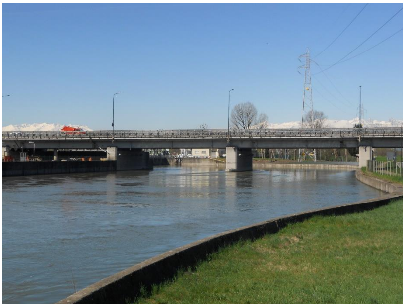
Il canale deviatore e la Diga del Pascolo
