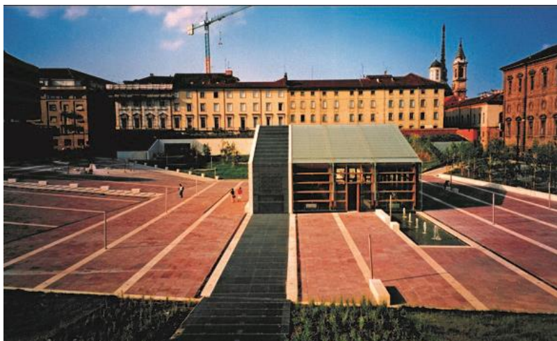
Il piazzale a termine realizzazione
