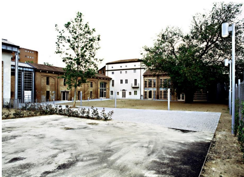
La pavimentazione della corte a progetto realizzato
