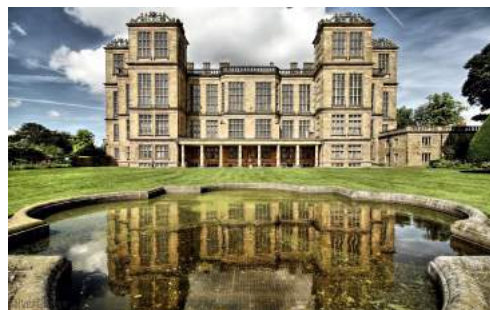
Fig.10 | Hardwick Hall, Derbyshire Una delle prime case di campagna realizzate nello stile architettonico rinascimentale inglese nel XVI secolo. Da notare la grande quantità di superficie vetrata.
