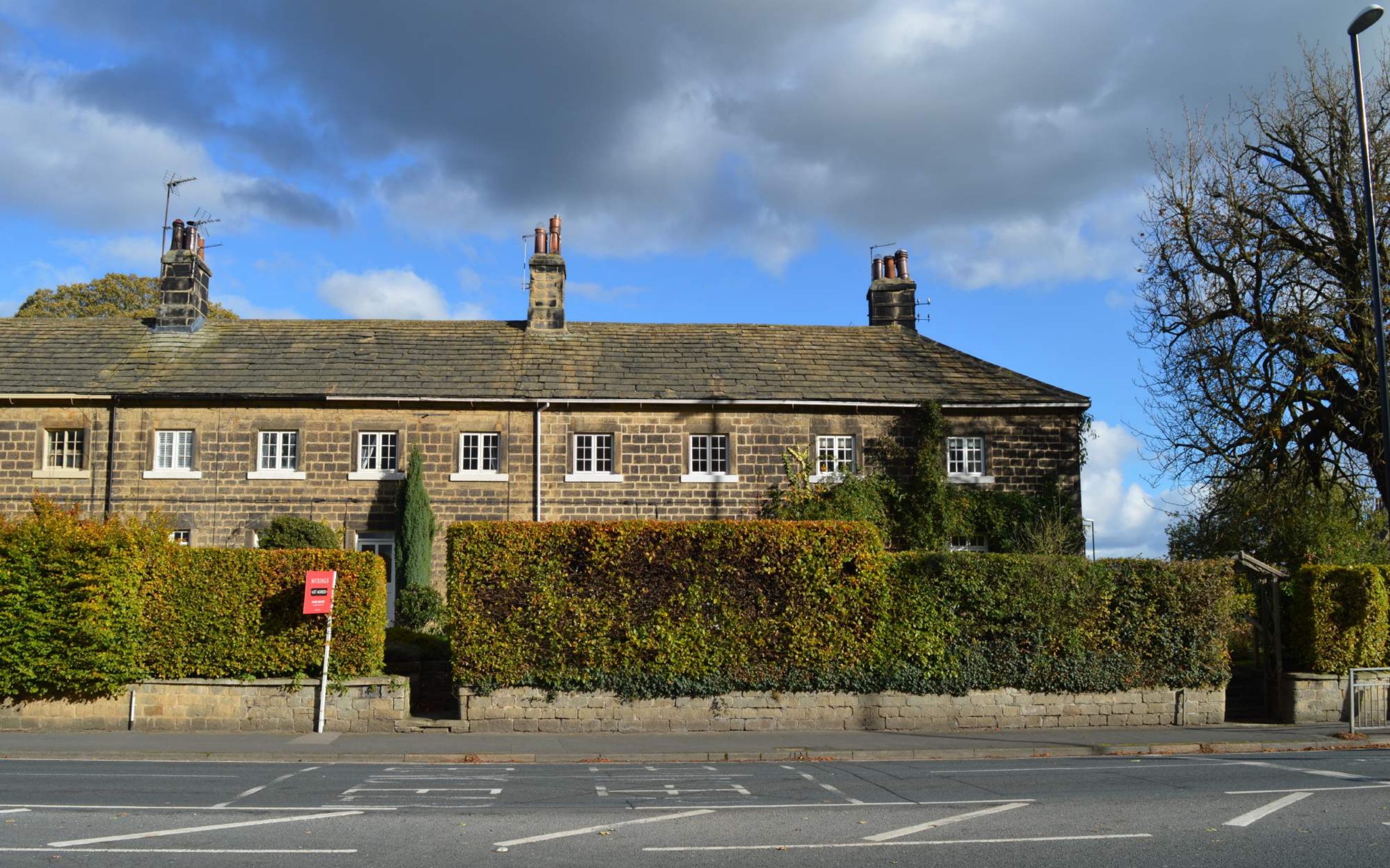
Fig.97 | Harewood, Yorkshire | Foto dell'autore, 2018. Così come la villa, anche le abitazioni del villaggio sono caratterizzate da un lessico uniforme, riconoscibile da alcuni elementi tipici dell'architettura georgiana, come le finestre e i camini.
