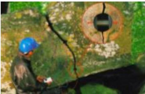
Figura 53. Fratturazione della roccia utilizzando elementi in SMA
