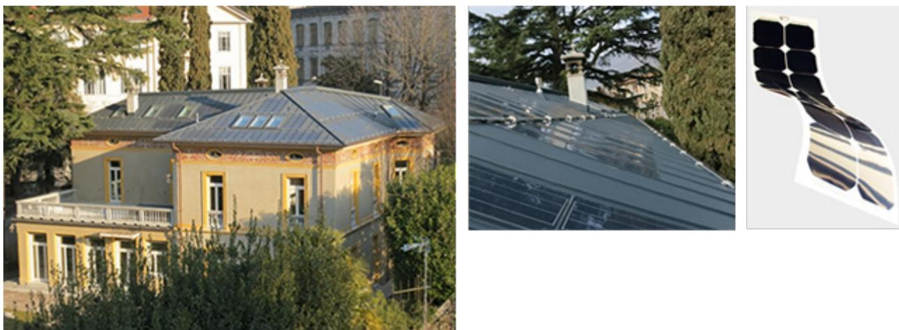
Per il quartiere si è quindi pensato di installare negli edifici con carattere storico, ossia realizzati prima del 1945, il fotovoltaico in film sottili, mentre nei restanti edifici i pannelli fotovoltaici tradizionali.
