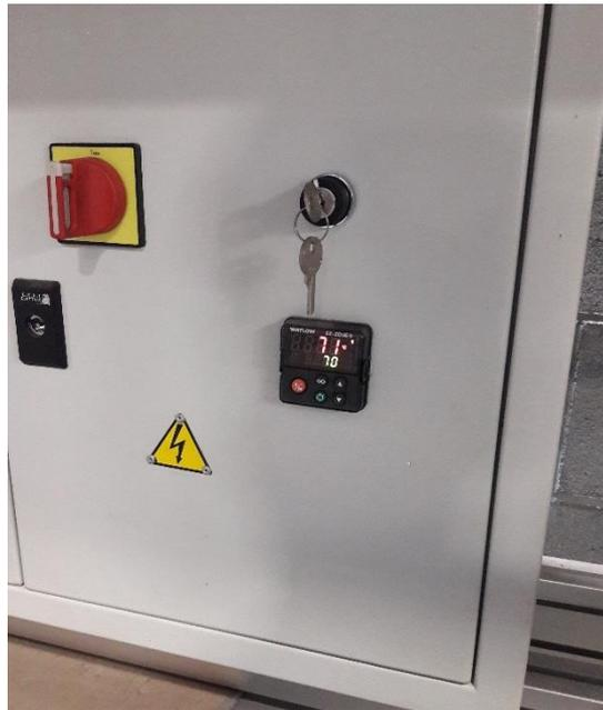
Fig. 4.3.7 Termostato che regola la temperatura del bancone di saldatura.
