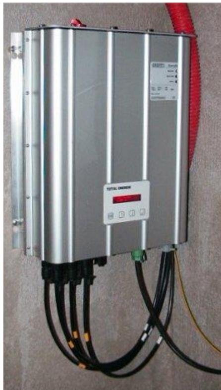
Fig. 1.5.1.3 Esempio di inverter fotovoltaico per immissione in rete. A sinistra gli ingressi delle stringhe dei moduli, a destra l'uscita monofase verso la rete in corrente alternata.
