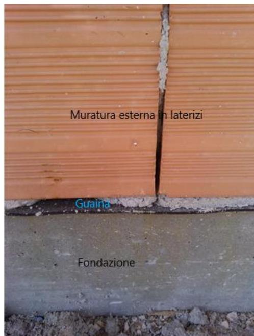
**Figura 7.7 - Particolare della guaina impermeabile disposta sotto i muri di compagno esterni**
