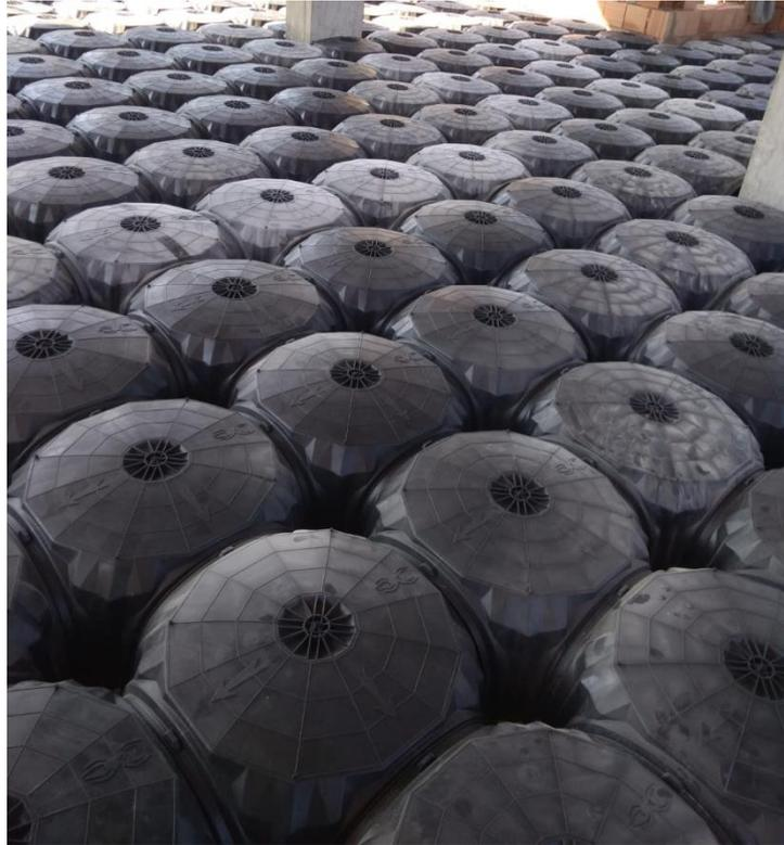
**Figura 7.5 - Igloo assemblati ad incastro per la realizzazione del vespaio aerato**
