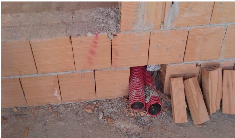
**Figura 7.6 - Fori di aerazione per permettere la ventilazione del vespaio**
