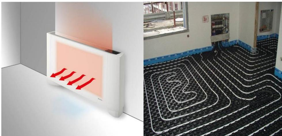
Figura 7 Ventilconvettore a sinistra, pannello radiante a pavimento sulla destra
