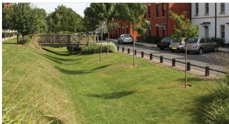
**Figura 2. 8** : Esempio di una trincea drenante [6].
