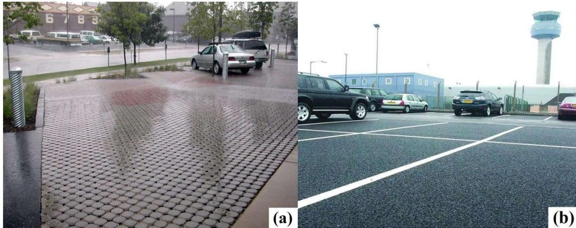
**Figura 2. 6 :** a) Parcheggio formato da pavimentazione modulare in blocchi [17].
