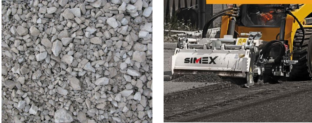
Figura 2.3: RAP; Fresa stradale al lavoro
