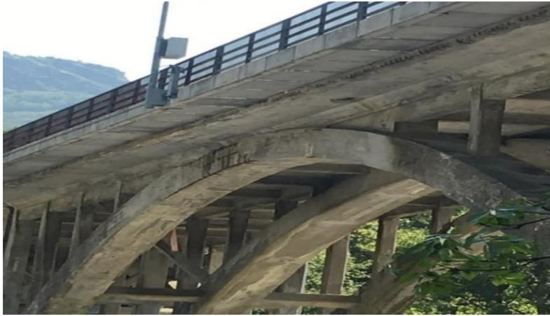
**Figura 5.** Ponte Lamberti, spalling del copriferro in corrispondenza della campata centrale.
