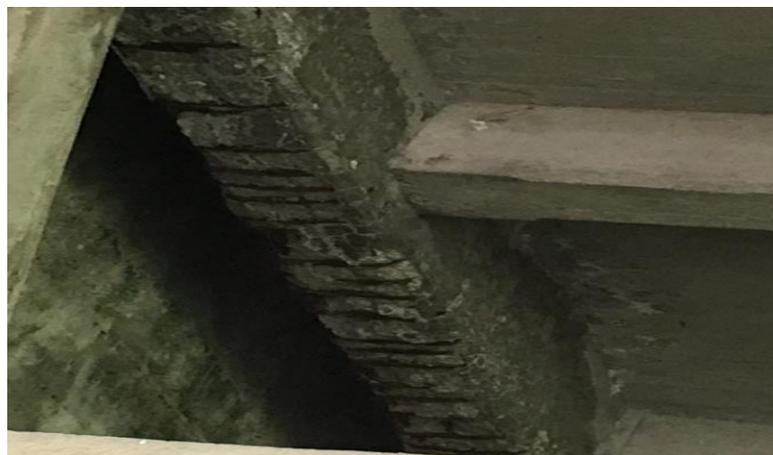
**Figura 6.** Barre d'armatura a taglio di una delle travi longitudinali esposte all'aria e corrose.
