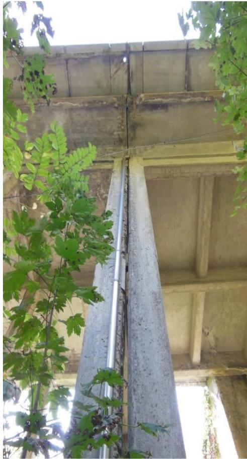
**Figura 4.**Discontinuità dell'impalcato ed esposizione a fenomeni di martellamento in presenza di sisma.
