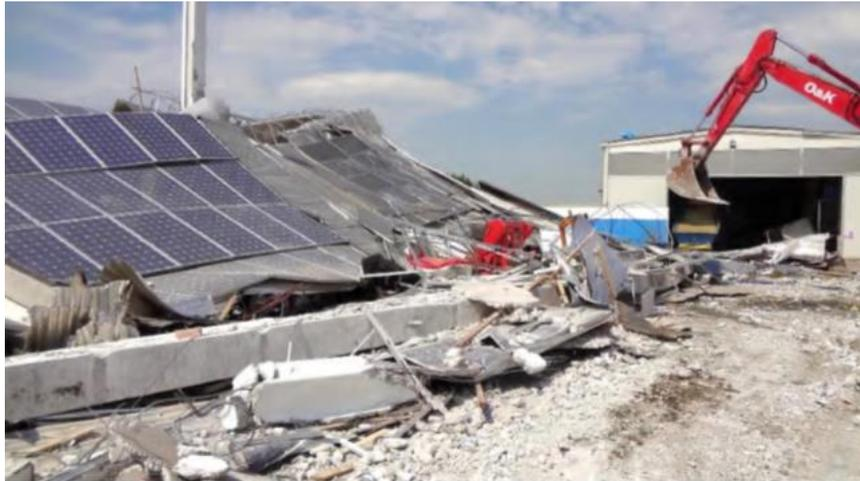
**Figura 6.** Crollo edificio dotato di impianto fotovoltaico nel sisma in Emilia-Romagna del 2012 [Negro et al., 2015]
