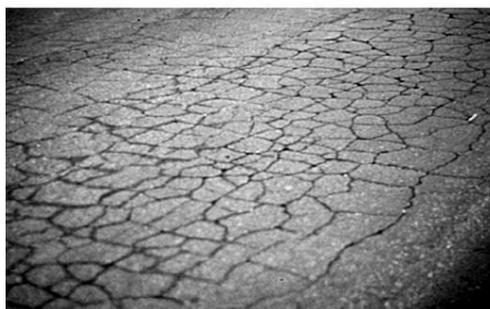
*Figura 1 Fessurazione a "pelle di cocodrillo" (Riviera, 2016/2017)*
