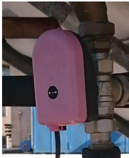
Figura 8.9 – Valvola motorizzata
