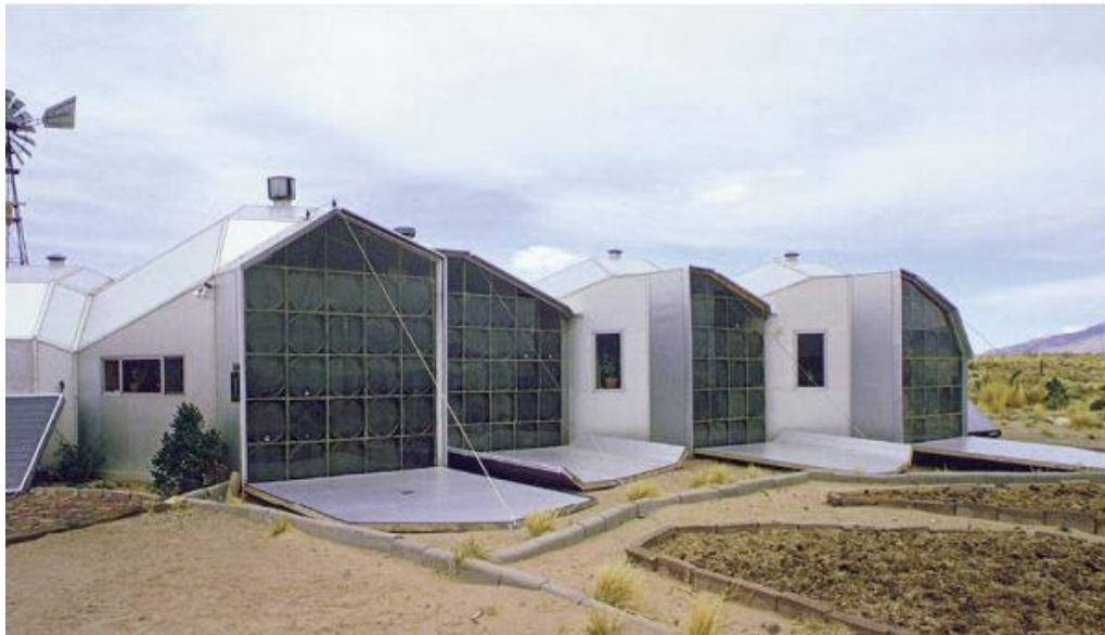
Figura 5.6 – Steve Baer, abitazione con il Water Drum Wall, Corrales, New Messico (1972)
