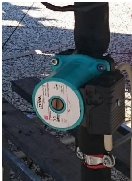
Figura 8.7 – Pompa sul ramo di ricircolo dell'utenza
