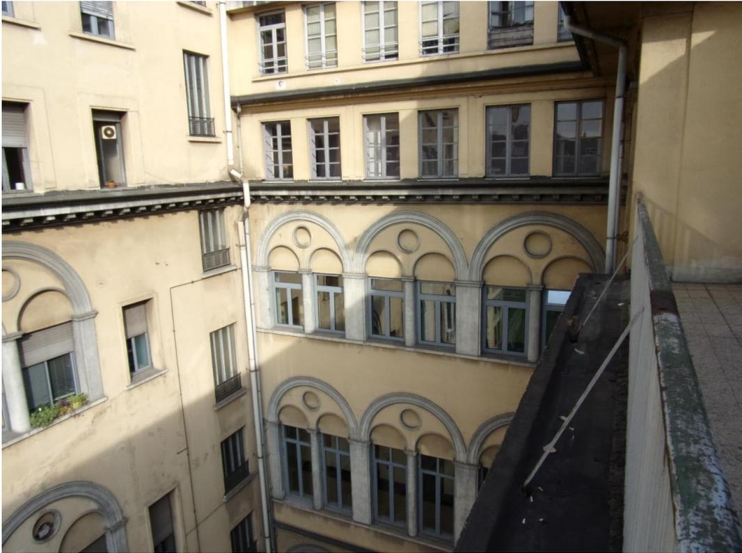
**Fig. 3.4.7** - Facciata lato cortile rampa, manica di via Juvarra, serramenti da piani primo e secondo (in alluminio, certificati), a terzo e quarto (in legno a vetro singolo, non certificati)
