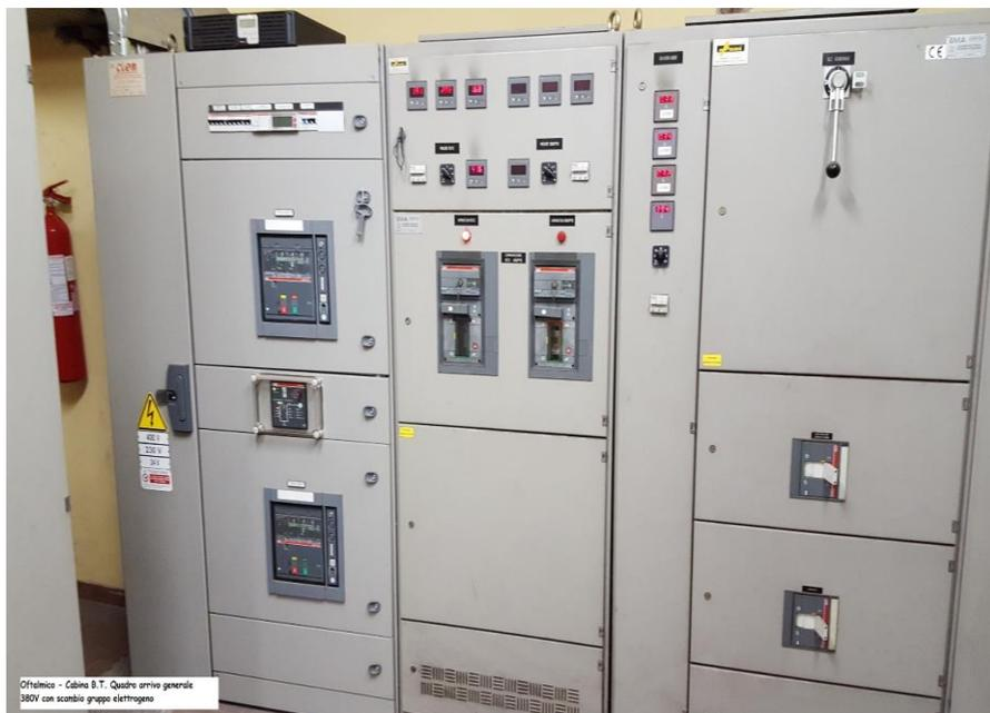
**Fig. 2.5.5 - Particolare quadro TLC Gruppo Elettrogeno / RETE**
