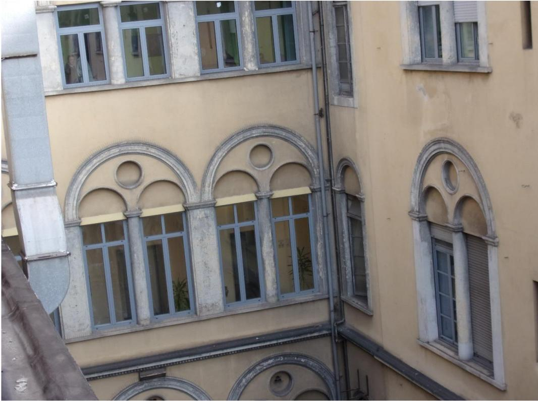
**Fig. 3.4.9-** Facciata lato cortile asfaltato manica di via Juarra, serramenti piani primo e secondo (in alluminio, certificati).
