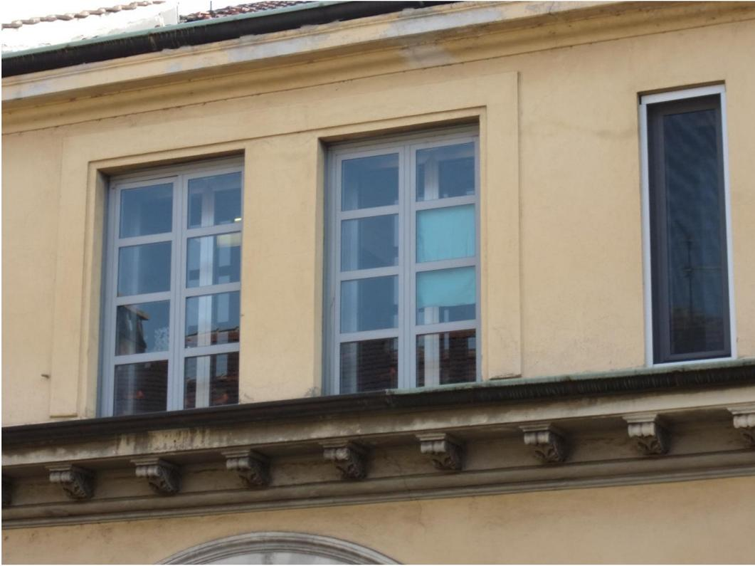
**Fig. 3.4.8** -Serramenti piano terzo manica di via Manzoni, lato cortile, in alluminio e vetro camera non certificati
