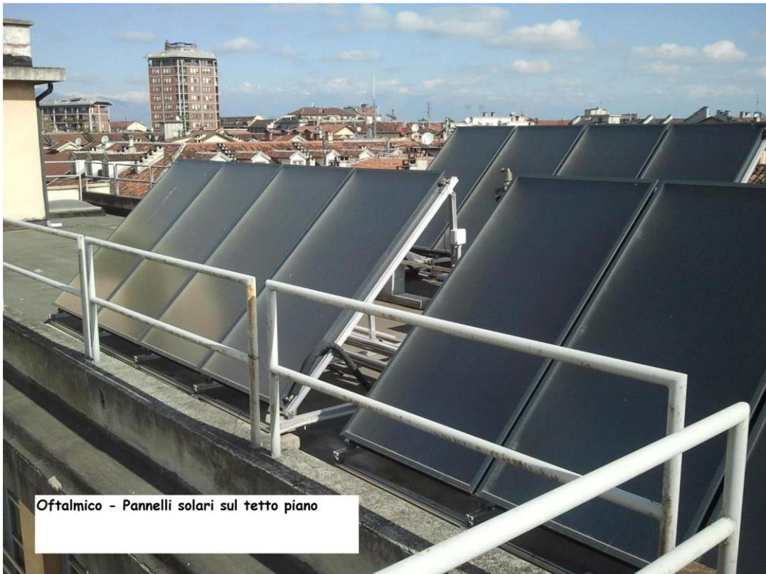
**Figura 2.5.3-**Collettori solari su copertura piana
