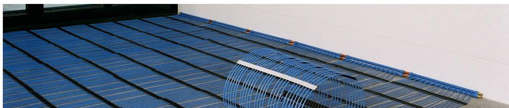
Figura 3.6: Installazione di un pavimento radiante a tubi capillari
