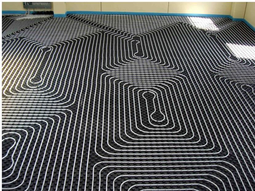
Figura 3.5: Installazione di un pavimento radiante con più circuiti
