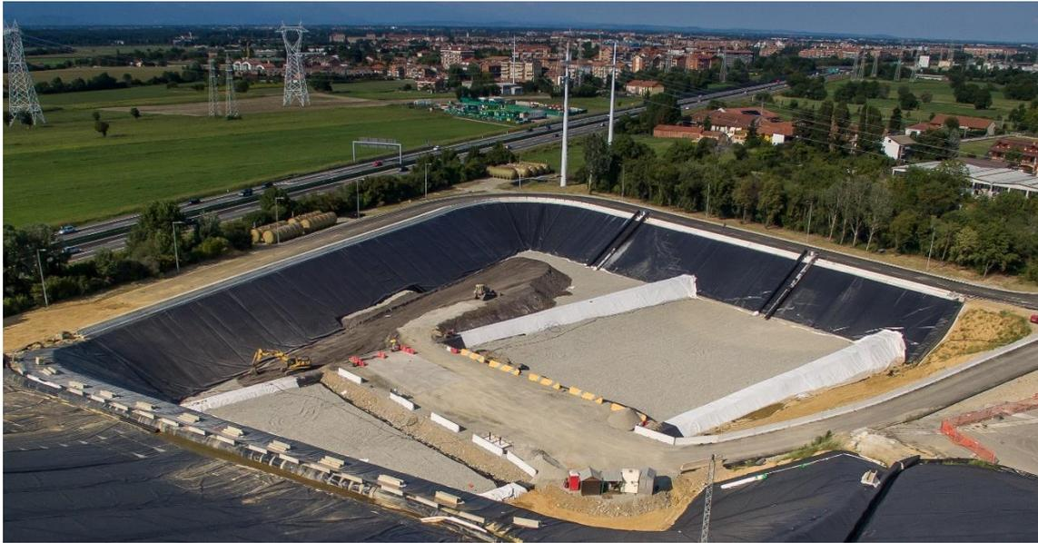
Figura 3.2 - Immagine aerea dello scavo e realizzazione del fondo
