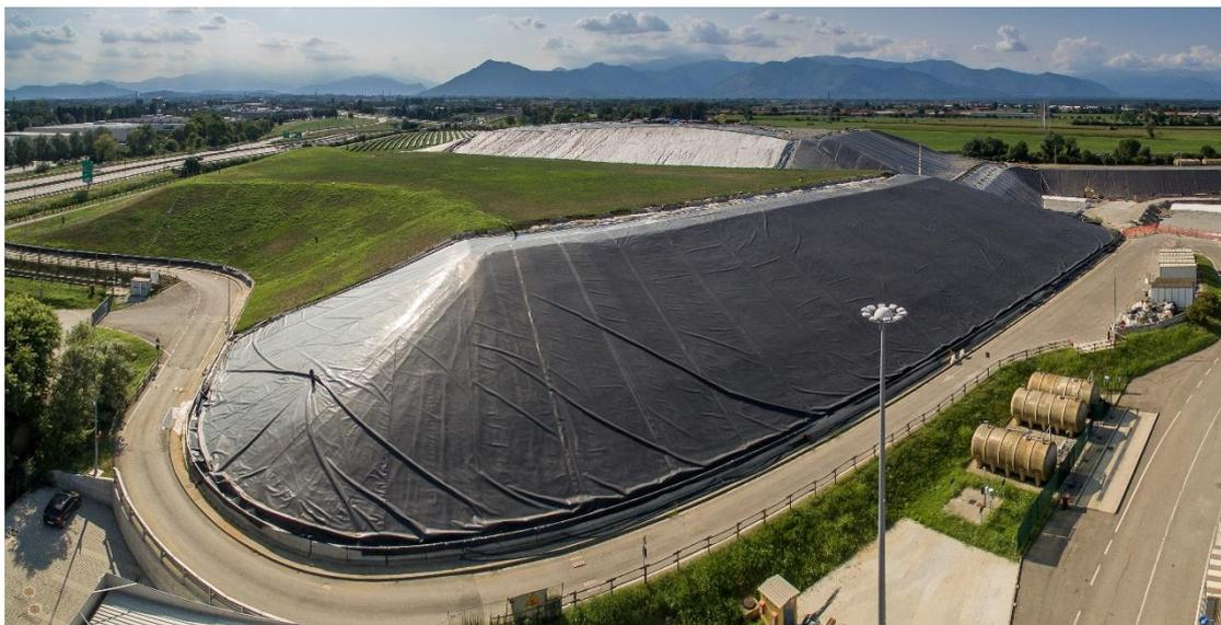
*Figura 3.3 – Realizzazione della copertura finale*
