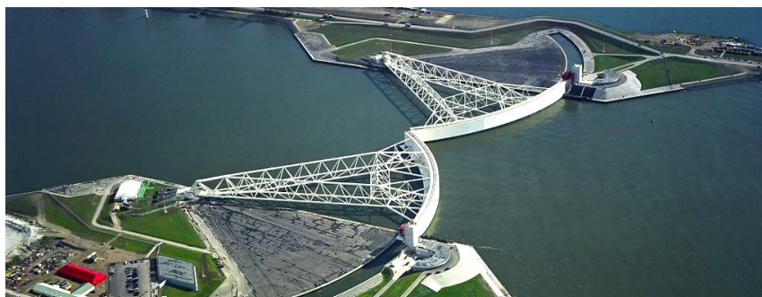
4.3.2 Struttura Maeslantkering, di contenimento delle acque per la protezione di Rotterdam. (oceans.mit.edu)
