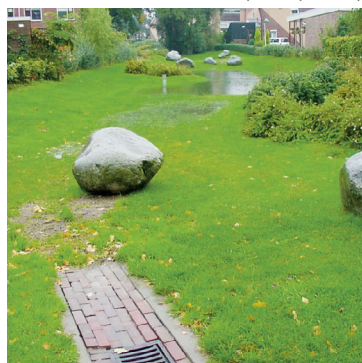
CANALE VERDE D'ACQUA a Mastbos, Paesi Bassi (Rainproof)
