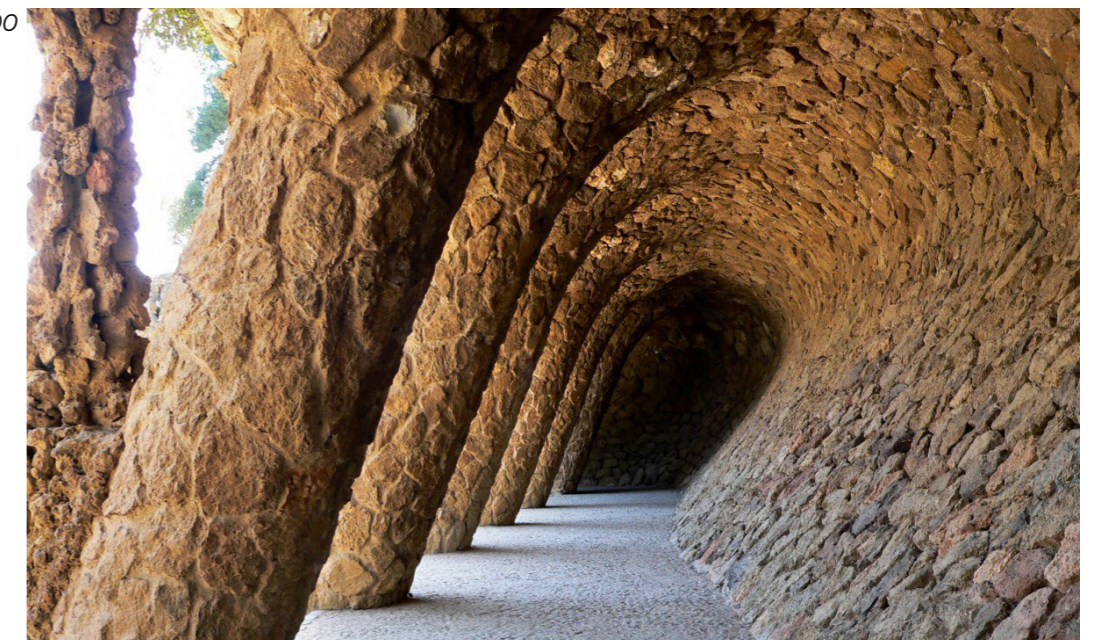
Fig.99) Viadotto di Parc Guell, Barcellona
