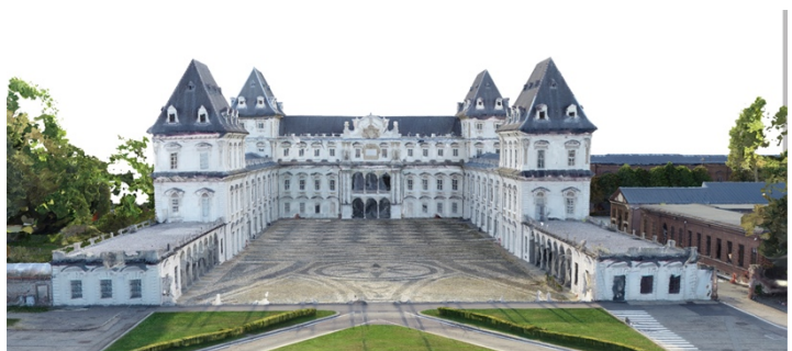
Figure 3 - Castello del Valentino, Modello 3D fotogrammetrico ottenuto con l'ausilio delle immagini sferiche.
