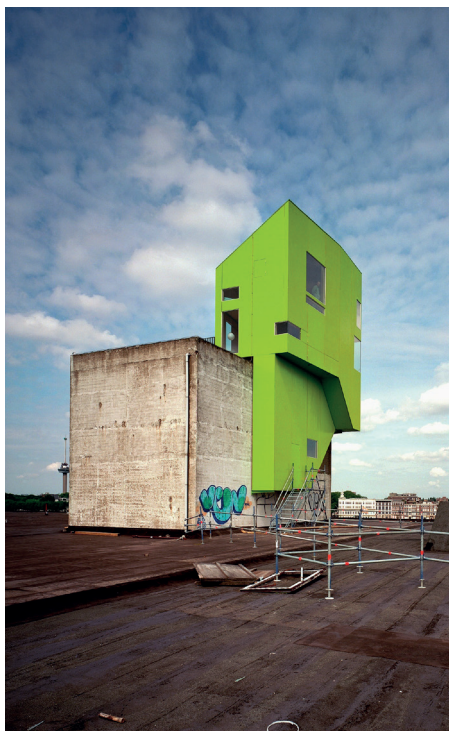
KorteKnie & Stuhlmacher Architects, Las Palmas parasite - Rotterdam, 2001. Questo edificio nasce per un'esposizione temporanea e consiste in un innesto moderno su di un magazzino abbandonato.
