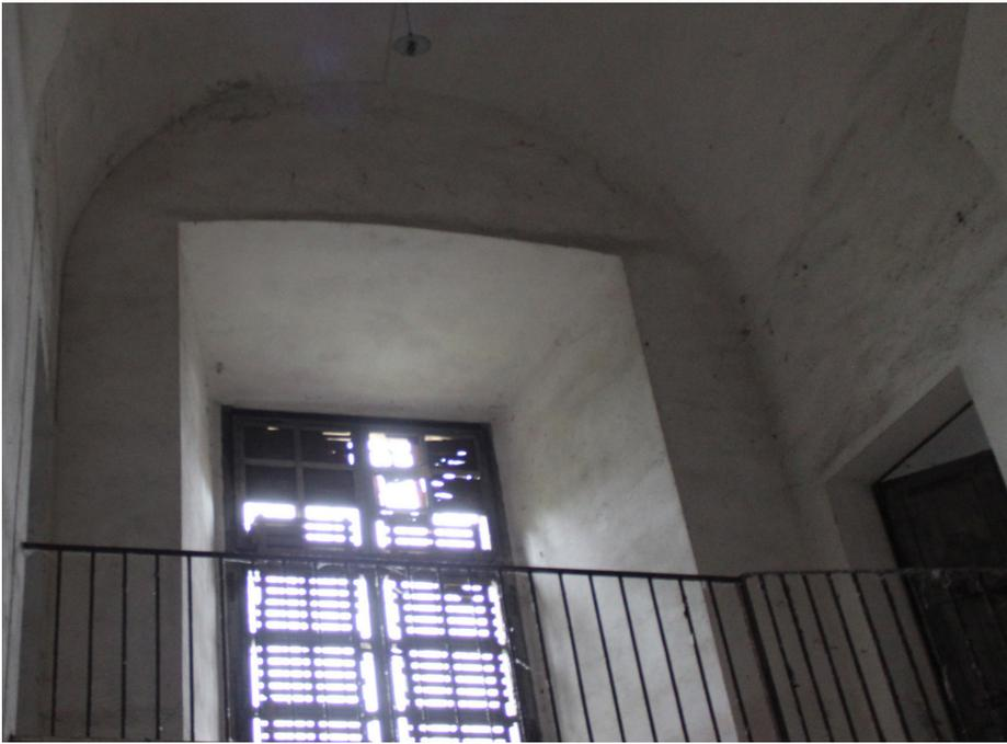
*Figura 23- Foto della volta del vano scala Sud, si nota la volta a botte rampante che si innesta nella volta a crociera centrale tra i due vani*
