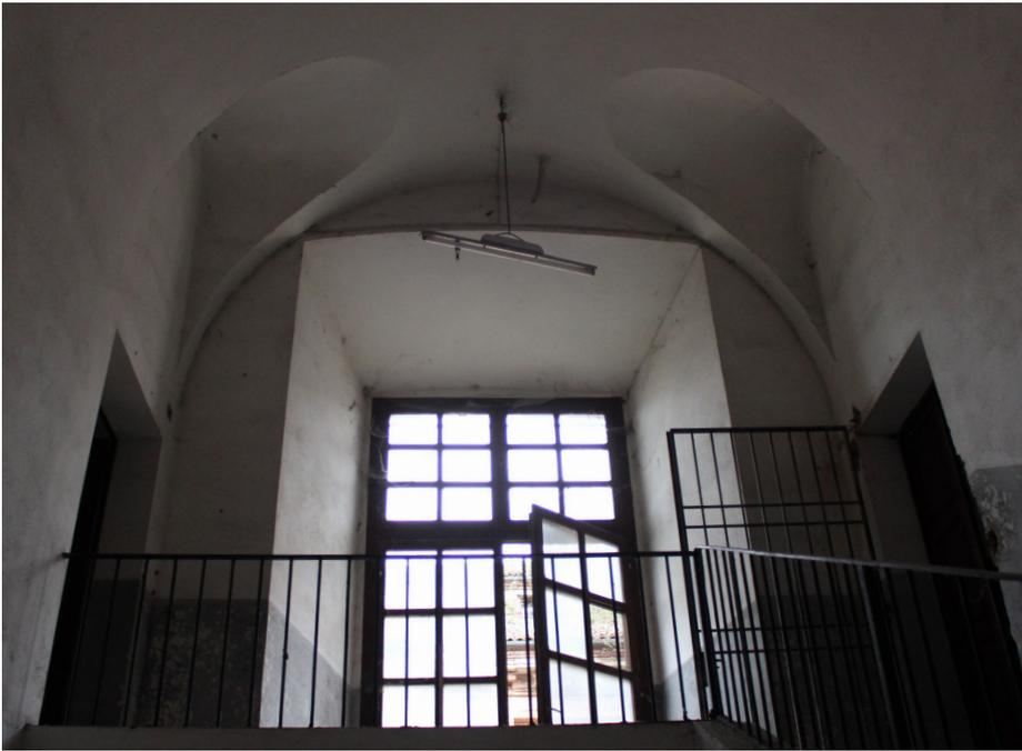
*Figura 24- Foto della volta del vano scala Nord, la volta è a botte con lunette in corrispondenza delle porte al pianerottolo. Il vano non è comunicante, la volta a botte si conclude sul muro di spina*
