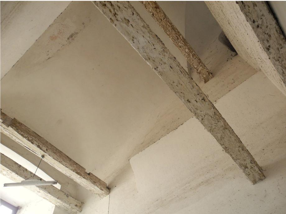
*Figura 26 - Foto delle travi di sostegno alla scala lignea di accesso ai corridoi superiori*
