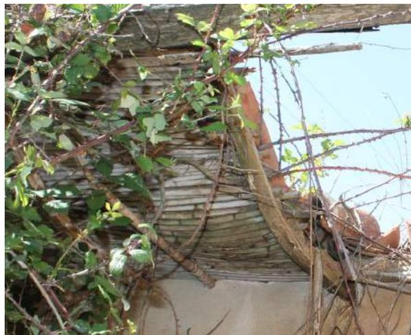
Fig. 41 < F7 Particolare dei resti dell'impalcato in canne con canna maestra visto dall'interno del nucleo originario. Foto dell'autore.
