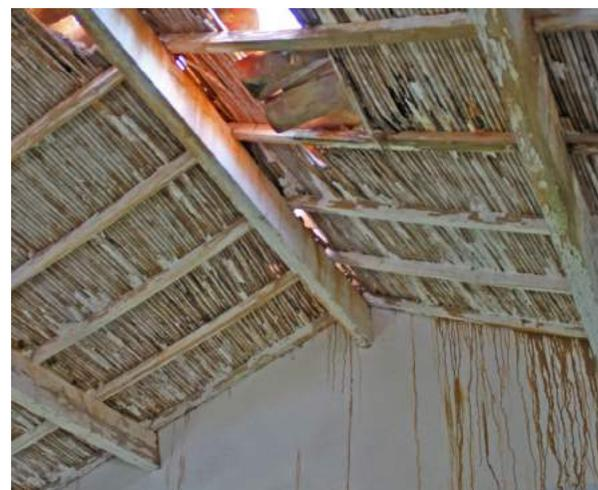
Fig. 59 < F7 Vista dell'intradosso della copertura sulla *appusèntu*. Al centro la trave di colmo, ai lati gli arcarecci rettangolari, sopra i travicelli quadrati e l'impalcato in canne. Foto dell'autore.
