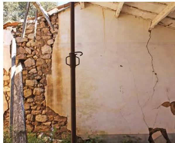
Fig. 101 < F6 Vista frontale del prospetto interno del muro laterale destro. Si nota la mancanza di intonaco e la tonalità della tinteggiatura. Foto dell'autore
