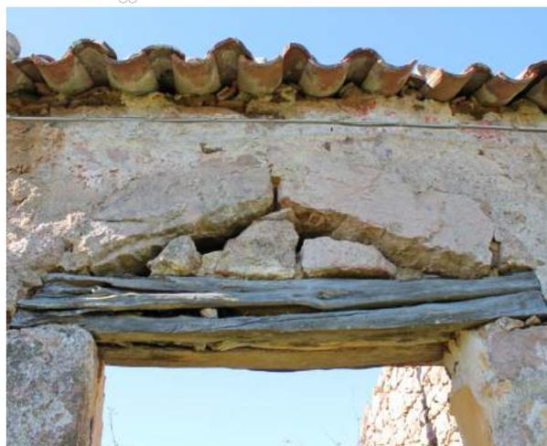
Fig. 60 < F8 Particolare della parte sommitale della porta esterna del nucleo originario. L'architrave ligneo poggiante su stipiti monolitici è sormontato da un triangolo di scarico. Foto dell'Autore.
