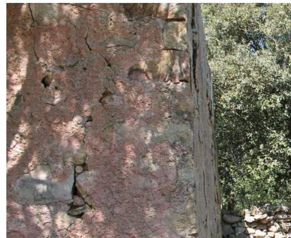
Fig. 103 < F8 Particolare sulle fessure superficiali sul fronte anteriore in prossimità del cantonale destro. Foto dell'Autore.
