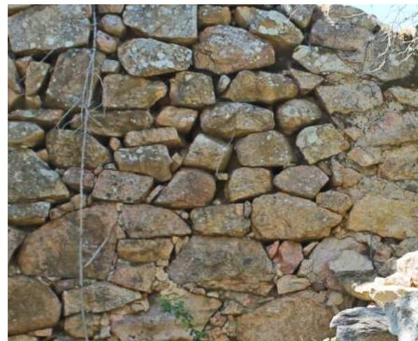
Fig. 87 < F14 Particolare della muratura in pietra grezza con conci di pezzatura prevalentemente medio piccoli del fronte laterale destro. Foto dell'Autore.
