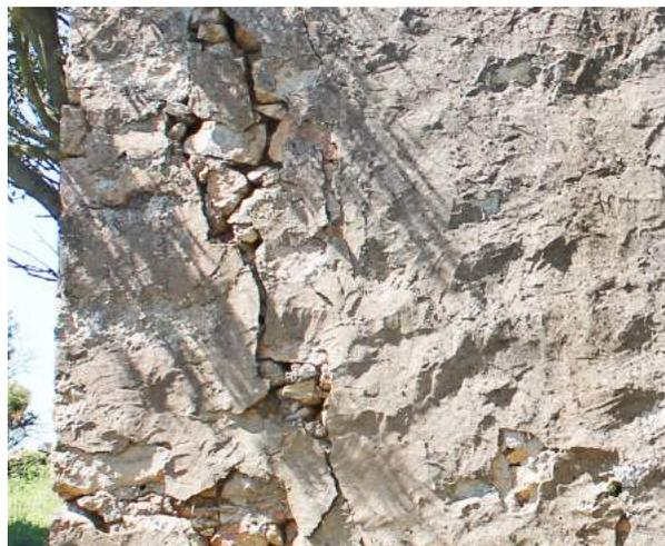
**Fig. 108** < F13 Particolare sulla fessura verticale sul fronte laterale destro in prossimità del cantonale sinistro. Foto dell'autore.
