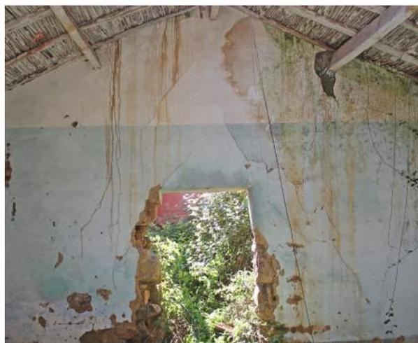
Fig. 38 < F3 Parete centrale vista dall'interno della *càmbara*, intonacata e tinteggiata con porta senza strombatura costruttivamente del tipo con architravi lapidei. Foto dell'Autore.
