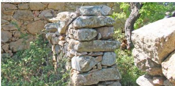
Fig. 74 *Lu murufòssu*, muro a secco dotato di fondazione. In sezione è costituito da due paramenti affiancati collegati mediante diatoni e rinzepature. Loc. *Albitu*, Aglientu (OT). Foto dell'autore.
