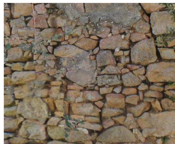
Fig. 123 MG2i Particolare della muratura in pietra grezza con conci dalle dimensioni prevalentemente medio-piccole sul fronte sinistro dell'Edificio 4. Foto dell'Autore.
