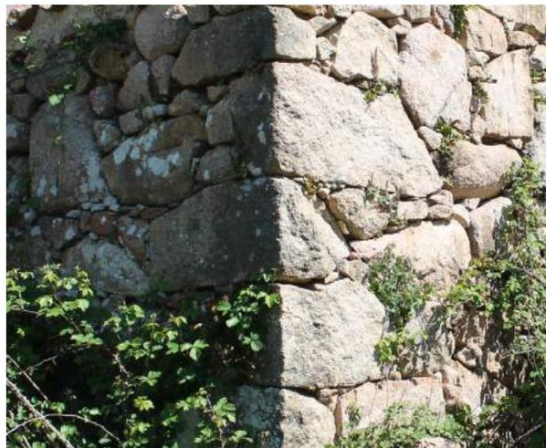
Fig. 125 CM0 Particolare della connessione tra muri ortogonali ammortati nel caso di paramenti con pietre di pezzatura prevalentemente medio-grande. Fronti sx/post. Edificio 1 Foto dell'Autore.
