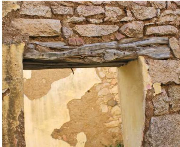
Fig. 130 AL Particolare dell'Apertura con Architravi Lignei. Si notano l'architrave e gli stipiti senza strombatura. Porta interna dell'Edificio 2, prospetto lato *casa manna*. Foto dell'Autore.
