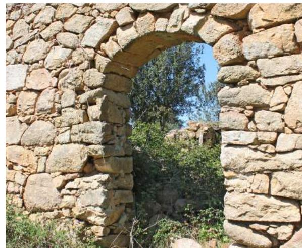
Fig. 81 < F8 Vista sulla porta con arco a sesto ribassato lapideo e stipiti ammassati che consente l'accesso all'edificio sul fronte anteriore. Foto dell'Autore.
