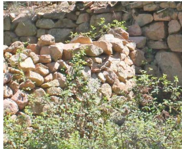
Fig. 85 < F12 Particolare dell'accostamento tra il muretto a secco esterno e il fronte posteriore. Foto dell'autore
