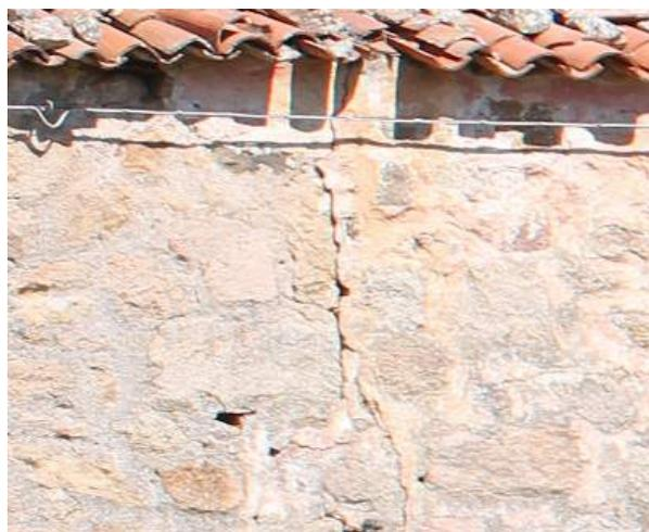
Fig. 58 < F6 Particolare, visibile sul fronte anteriore, della connessione senza ammorsamento tra i muri contigui del nucleo originario e il vano aggiunto. Foto dell'Autore.
