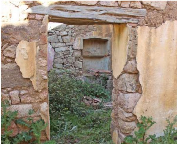
Fig. 129 AL Particolare dell'Apertura con Architravi Lignei. Si notano l'architrave e gli stipiti ammosati senza strombatura. Porta interna dell'Edificio 2, prospetto lato *càmbara*. Foto dell'Autore.
