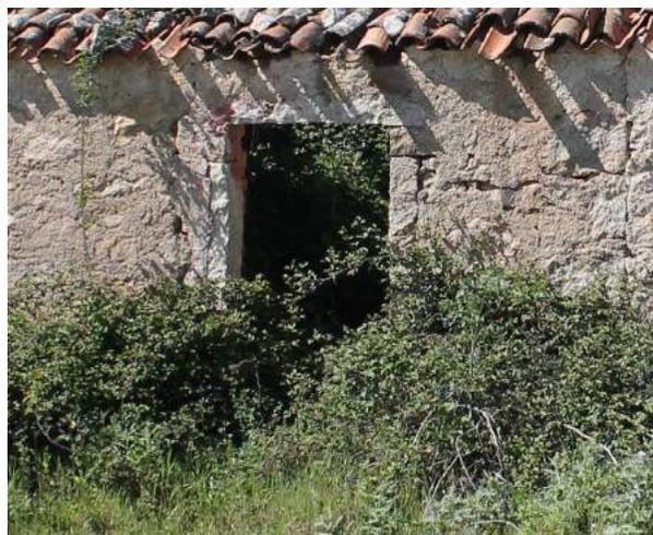
Fig. 43 < F9 Vista del prospetto esterno della porta d'ingresso al primo vano, con architrave lapideo e stipiti parzialmente ammassati. Foto dell'autore.
