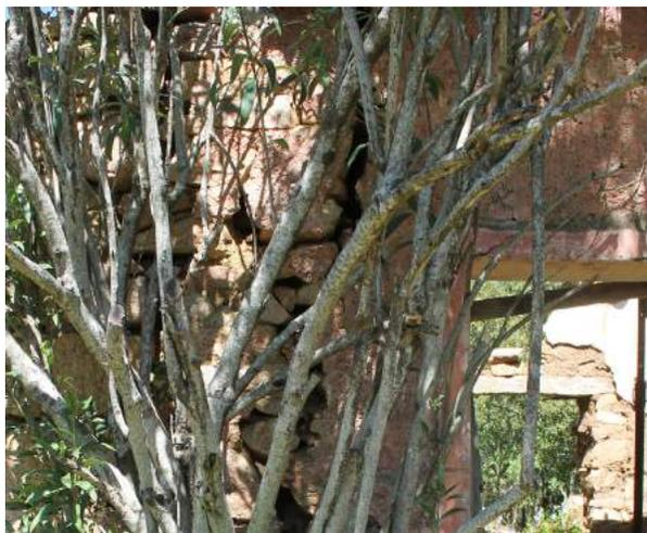
Fig. 102 < F7 Particolare sulla lesione verticale sul fronte anteriore in prossimità del cantonale sinistro. Foto dell'autore.
