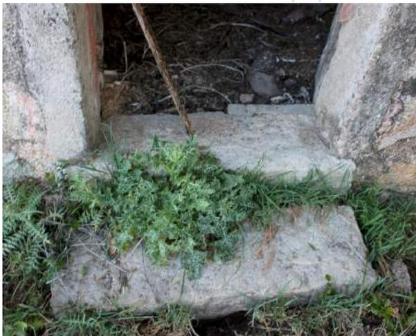
Fig. 142 APL Particolare dell'Apertura con Architravi Lapidiei e Lignei. Si notano i due gradini costituenti il *mitàli*. Porta esterna laterale, Ed.2, vista verso il basso del prospetto esterno.
