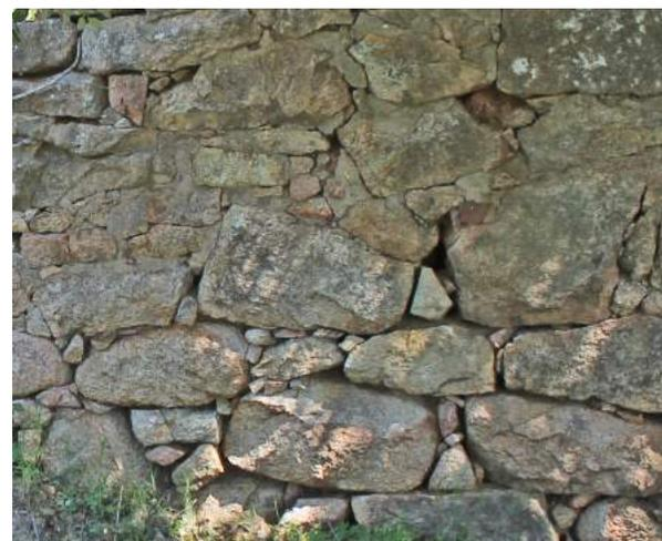
Fig. 89 < F16 Particolare della muratura in pietra grezza con conci di pezzatura prevalentemente medio grande del fronte laterale sinistro. Foto dell'autore.
