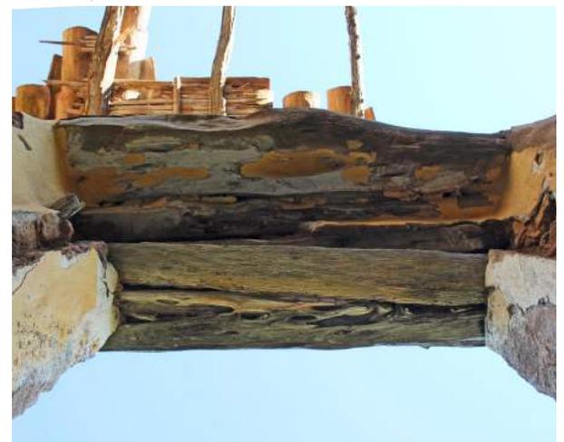
Fig. 134 ALS Particolare dell'Apertura con Architravi Lignei e Triangolo di scarico. Si nota la successione degli architravi nello spessore. Porta esterna centrale, Ed.2, vista intradosso del vano.
