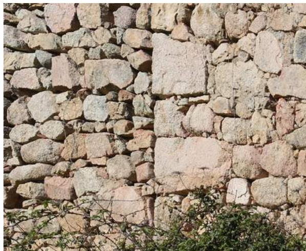
Fig. 68 < F16 Particolare sul giunto di connessione tra la muratura del nucleo originario e quella del *pinnènti*. È evidente il non ammorsamento ma il semplice affiancamento. Foto dell'Autore.
