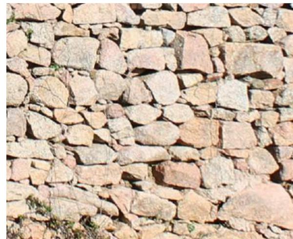
Fig. 121 MG2 Particolare della muratura in pietra grezza con conci di pezzatura prevalentemente medio-piccola sul fronte sinistro dell'Edificio 2. Foto dell'Autore.
