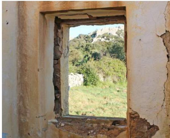
Fig. 140 APL Particolare dell'Apertura con Architravi Lapidiei e Lignei. Si nota l'imbotte strombata, l'incavo della mazzetta e della soglia. Finestra su fronte anteriore, Ed.2, prospetto interno.
