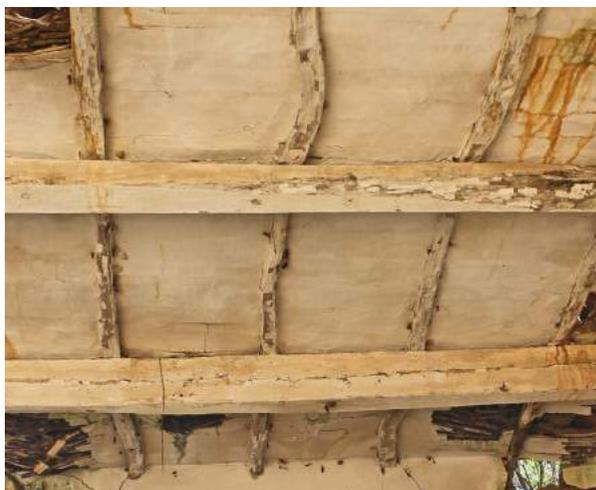
Fig. 106 < F11 Vista dell'intradosso della copertura esistente sulla falda anteriore. Si possono vedere gli arcarecci, i travicelli e l'impalcato in canne intonacato. Foto dell'autore.
