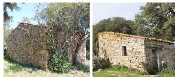
Fig. 2 Stazzi monocellulari: a sinistra la variante a doppio spiovente, Complesso di Stazzi L'Albitu, loc. Albitu, Aglientu (OT); a destra la variante ad uno spiovente, Stazzo Mezzaustu, loc. Mezzaustu, Tempio Pausania (OT). Foto dell'autore.
