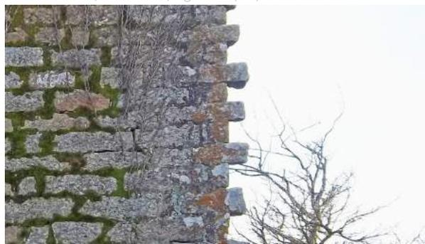
Fig. 32 Morse d'attesa, soluzione d'angolo che prevede la sporgenza degli ortostati in modo da garantire un buon ammorsamento dei muri in caso di ampliamento. Stazzo *Mulaglia*, loc. *Mulaglia*, Tempio Pausania (OT). Foto dell'autore.
