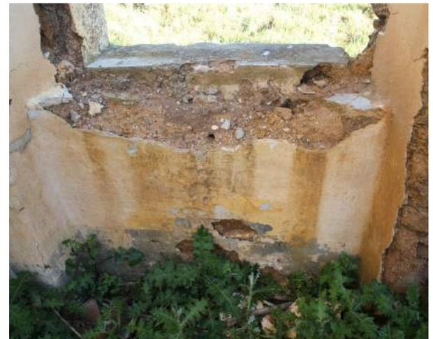
Fig. 144 APL Particolare dell'Apertura con Architravi Lapidiei e Lignei. Si nota la strombatura fino a terra e la soglia mancante. Finestra su fronte anteriore, Ed.2, vista verso il basso, prospetto int.
