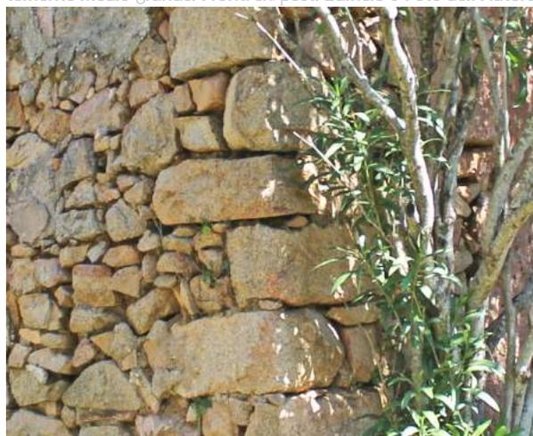
Fig. 126 CM0 Particolare della connessione tra muri ortogonali ammortati nel caso di paramenti con pietre di pezzatura prevalentemente medio-piccole. Fronti sx/ant. Edificio 4. Foto dell'Autore.
