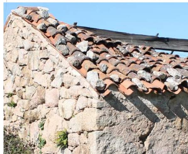
Fig. 48 < F14 Soluzione di gronda con aggetto semplice dei coppi canale sul prospetto laterale sinistro. Foto dell'autore.
