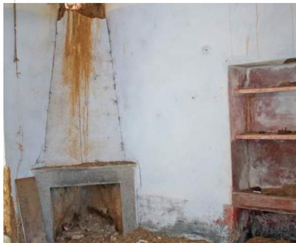
Fig. 56 < F4 Vista dell'interno dell'*appusèntu* sul camino ad angolo con cappa in pietrame e terra e la nicchia con mensole di legno. Foto dell'Autore.
