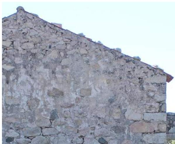
Fig. 64 < F12 Fronte destro dell'*appusèntu* in cui si può osservare l'inclinazione della falda, la soluzione di gronda con aggetto semplice dei coppi canale e il cantonale ammorsato. Foto dell'autore.
