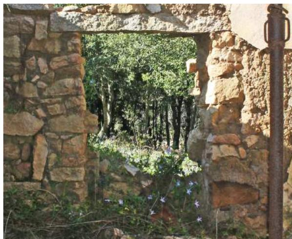
Fig. 98 < F3 Vista del prospetto interno della finestra con architrave lapideo, stipiti ammorsati e parapetto senza soglia. Foto dell'Autore.
