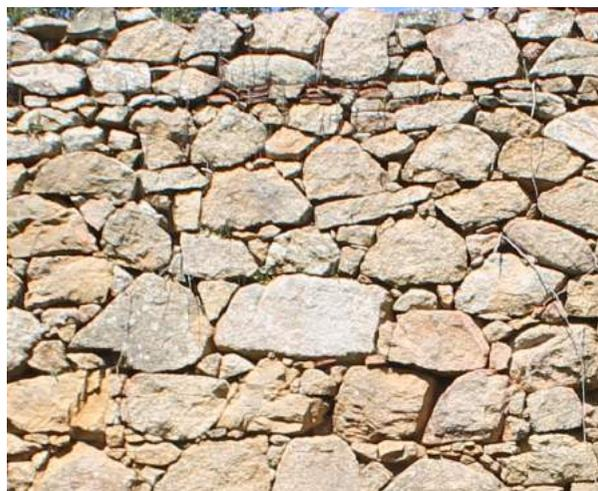
Fig. 118 MG1 Particolare della muratura in pietra grezza con conci di pezzatura prevalentemente medio-grandi sul fronte anteriore dell'Edificio 3. Foto dell'autore.
