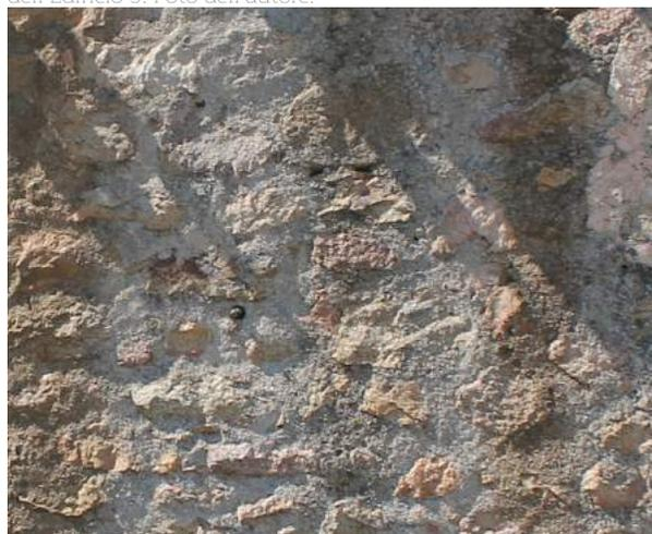
Fig. 120 MG1i Particolare della muratura in pietra grezza con conci di pezzatura prevalentemente medio-grande e intonaco sul fronte anteriore dell'Edificio 2. Foto dell'Autore.
