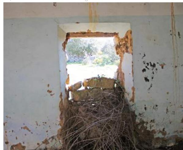
Fig. 39 < F4 Vista interna della finestra della *càmbara* del tipo con architrave esterno lapideo e interni lignei. È visibile la strombatura e la parziale chiusura provvisoria con pietre. Foto dell'Autore.
