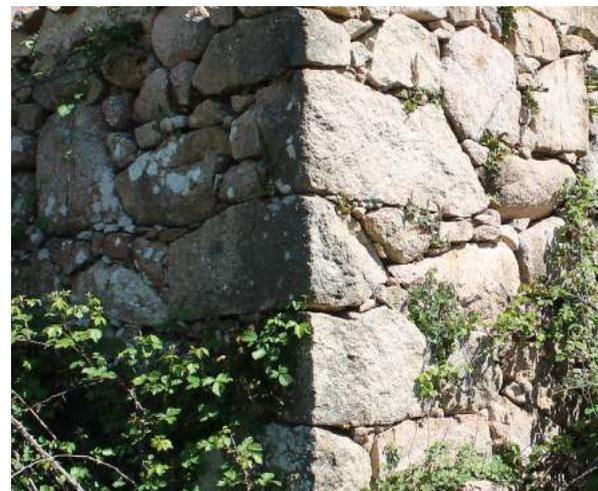
Fig. 46 < F12 Vista del cantonale del vano a sinistra, realizzato con pietre non sbazzate e di dimensioni piuttosto grandi rispetto a quelle con cui è realizzata la muratura. Foto dell'autore.
