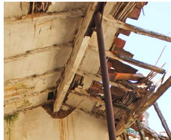
Fig. 107 < F12 Vista dell'intradosso della copertura. Al centro la trave di colmo puntellata, a destra la falda anteriore, a sinistra quella posteriore parzialmente crollata. Foto dell'autore
