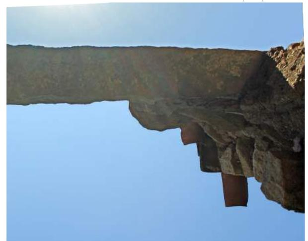
Fig. 147 AP Particolare dell'Apertura con Architravi Lapidiei. Si nota l'architrave poggiante su stipiti ammorsati senza strombatura. Finestra, Edificio 4, vista dell'intradosso del vano.
