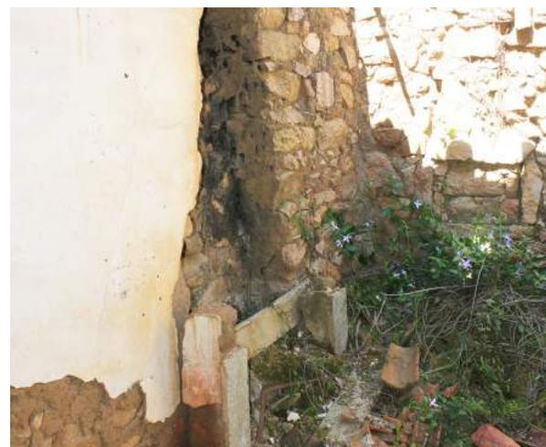
Fig. 97 < F2 Vista sul camino di cui resta la traccia della canna fumaria e alcuni elementi della bocca del focolare. Foto dell'Autore.
