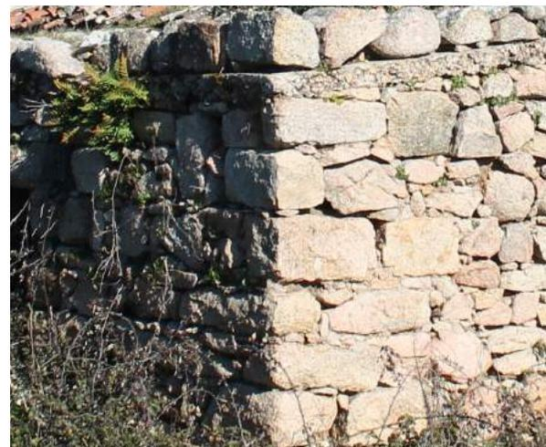
Fig. 69 < F17 Particolare del cantonale ben ammorsato realizzato con conci dalle dimensioni maggiori sullo spigolo sinistro del *pinnènti*. È visibile anche la traccia della soletta in c.a. Foto dell'autore.
