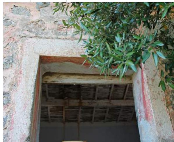
Fig. 61 < F9 Particolare della parte sommitale della porta esterna dell'*appusèntu*. Architrave lapideo e stipiti ammorsati sono coperti da una cornice d'intonaco. Foto dell'autore.
