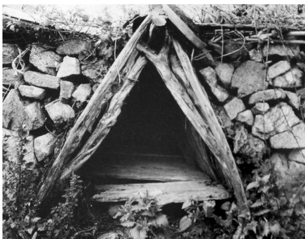
Fig. 51 *La bucca* di *lu salcòni*, ingresso a V rovesciata tipico del ricovero generalmente utilizzato per i capretti. Immagine tratta da: T. Maiore, Q. Mossa, *Stazzi di Gallura nel tempo*, Olbia, Altergrafica, 1993, p.28
