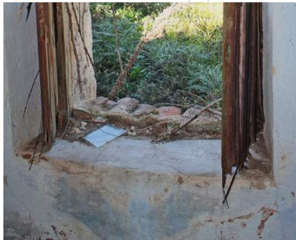
Fig. 143 APL Particolare dell'Apertura con Architravi Lapidiei e Lignei. Si nota la strombatura fino alla soglia in muratura intonacata. Finestra su fronte posteriore, Ed.2, vista verso il basso, pr. int.
