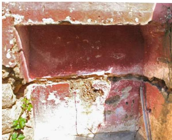
Fig. 36 < F1 Particolare della nicchia situata all'interno del nucleo originario sulla parete centrale. Sono evidenti i segni per l'incastro delle mensole dell' *almâdiu*. Foto dell'Autore.
