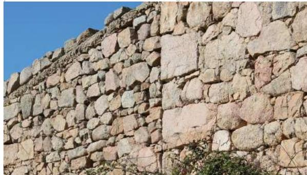
Fig. 31 Rapporto tra murature aggiunte e preesistenti: quando non era possibile effettuare la scucitura del cantonale le strutture venivano semplicemente affiancate e rese indipendenti. Complesso di stazzi *L'Albitu*, loc. *Albitu*, Aglientu (OT). Foto dell'autore.
