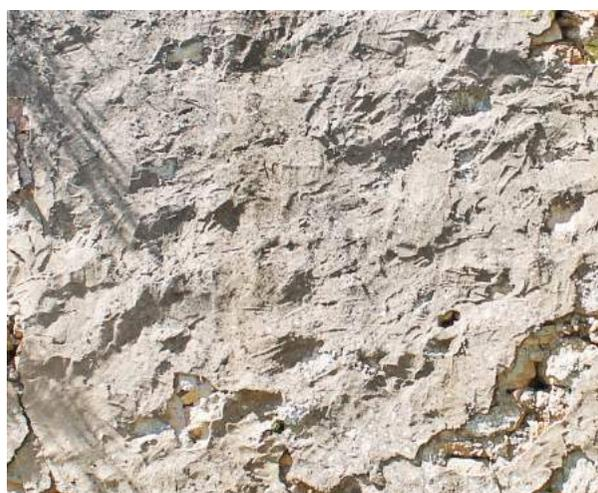
Fig. 122 MG2i Particolare della muratura in pietra grezza con conci di pezzatura prevalentemente medio-piccola sul fronte destro dell'Edificio 4. Foto dell'Autore.
