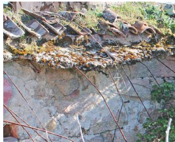
Fig. 67 < F15 Particolare sui resti della soletta in calcestruzzo armato che costituiva la copertura impropria del *pinnènti*. Foto dell'autore.
