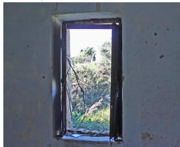
Fig. 55 < F3 Vista interna della finestra dell'*appusèntu* del tipo con architrave esterno lapideo e interni lignei. Sono presenti telaio fisso e mobile dell'infisso in legno. Foto dell'autore.
