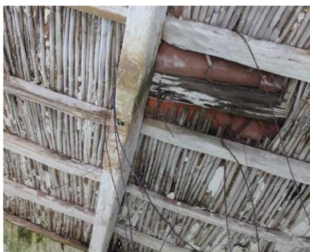
**Fig. 160** IC1 Copertura con Impalcato in Canne parallele senza canna maestra. Edificio 1, *càmbara*, vista dell'intradosso. Foto dell'autore.
