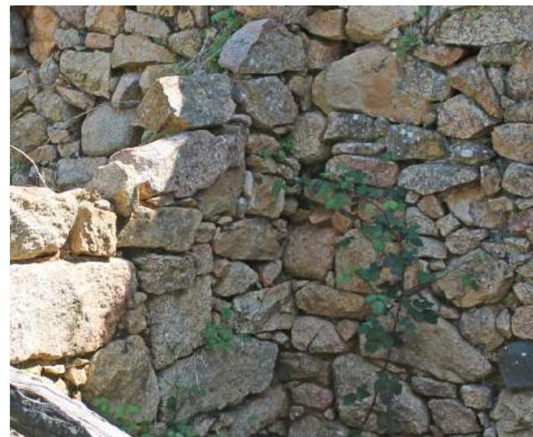
Fig. 75 < F2 Particolare dell'innesto del muro interno sul fronte anteriore, senza evidenti segni di ammorsamento. Foto dell'Autore.
