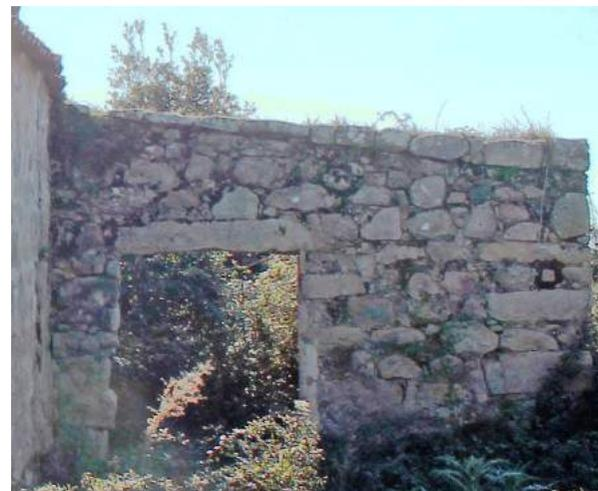
Fig. 65 < F13 Fronte destro del *pinnènti* con muro inclinato ad una falda e portale con architravi lapidei e stipiti ammorsati. Foto dell'Autore.
