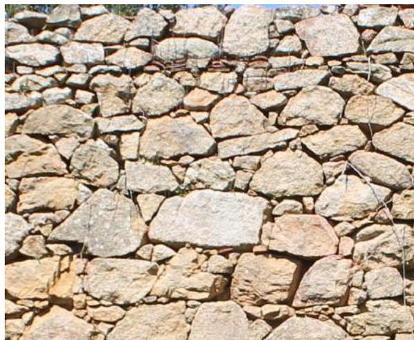
Fig. 80 < F7 Particolare della muratura in Pietra Grezza con conci di pezzatura prevalentemente medio-grandi sul fronte anteriore. Foto dell'autore.
