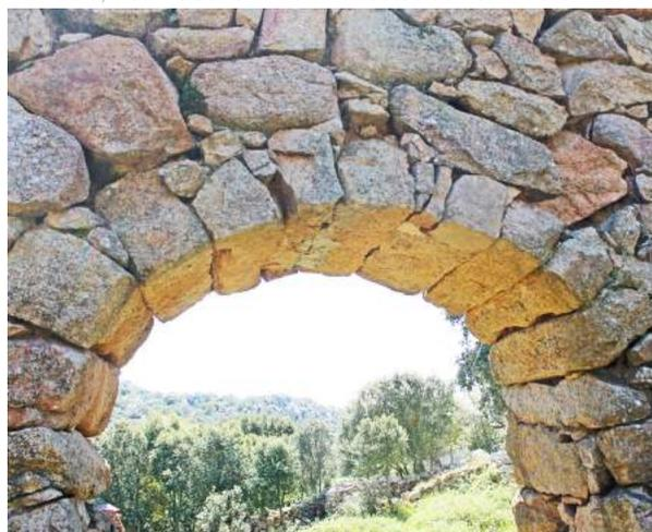
Fig. 152 AA Particolare dell'Apertura con Arco Lapideo. Si nota la geometria dell' arco a sesto ribassato e i conci d'imposta e in chiave. Porta, Edificio 3, prospetto interno. Foto dell'Autore.
