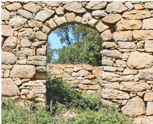
Fig. 149 AA Particolare dell'Apertura con Arco Lapideo. Si nota la geometria del vano con arco a sesto ribassato su stipiti ammassati. Porta, Edificio 3, prospetto esterno. Foto dell'Autore.
