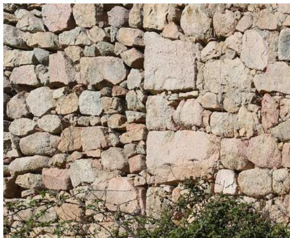
Fig. 127 CM1 Particolare della connessione tra muri contigui non ammortati nel caso di murature realizzate in epoche e con metodi differenti. Fronte sinistro Edificio 2 Foto dell'Autore.
