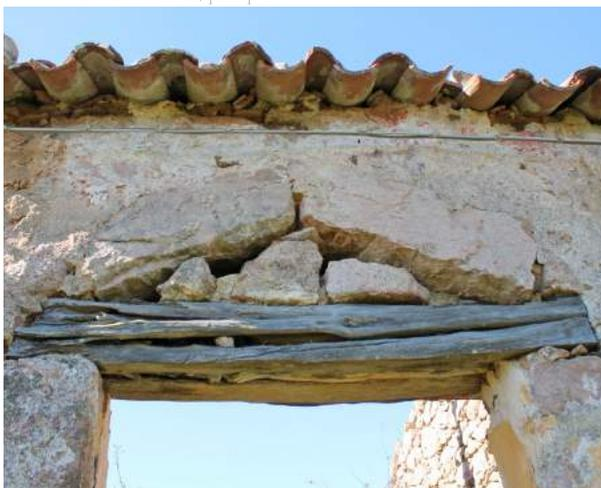
Fig. 132 ALS Particolare dell'Apertura con Architravi Lignei e Triangolo di scarico. Si nota l'architrave ligneo su stipiti monolitici con triangolo di scarico. Porta esterna centrale, Ed.2, prosp. esterno
