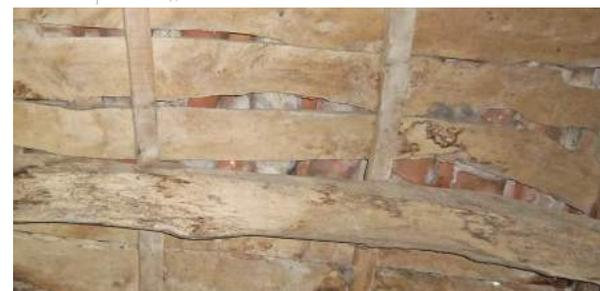
Fig. 21 Solaio di copertura realizzato con trave a sezione pseudo circolare, listelli a sezione quadrata e tavole non squadrate. Si tratta probabilmente di legno di quercia. Foto dell'autore.
