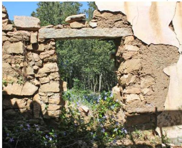
Fig. 146 AP Particolare dell'Apertura con Architravi Lapidiei. Si nota l'architrave poggiante su stipiti ammorsati senza strombatura e la soglia in muratura. Finestra, Edificio 4, prospetto interno.
