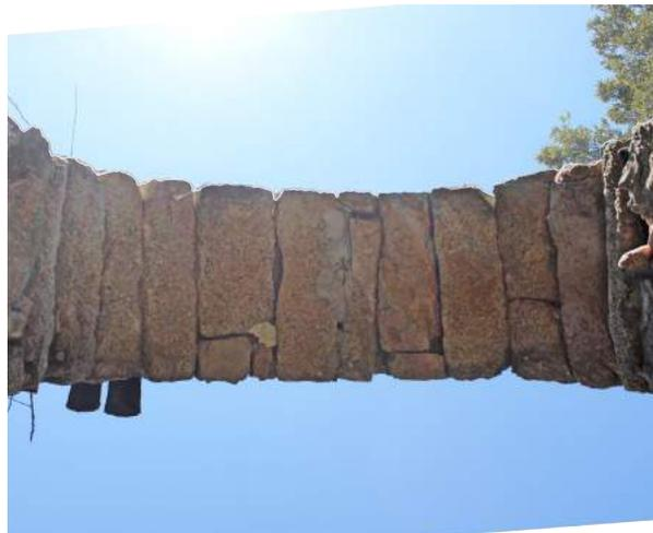
Fig. 150 AA Particolare dell'Apertura con Arco Lapideo. Si nota la disposizione dei conci che attraversano la sezione muraria Porta, Edificio 3, vista verso l'alto dell'intradosso del vano. Foto Autore.
