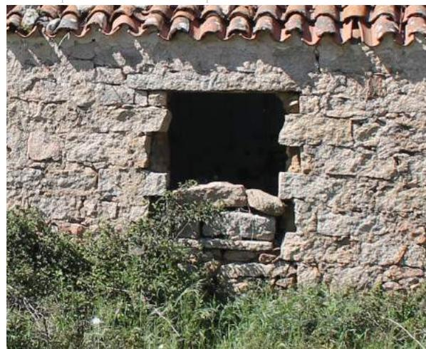
Fig. 44 < F10 Vista del prospetto esterno della finestra della *càmbara*, con architrave lapideo e stipiti ammassati. Sotto le pietre poste provvisoriamente per la chiusura vi è la soglia. Foto dell'autore.
