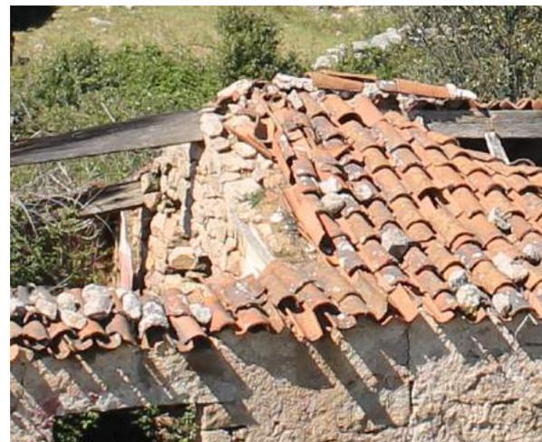
Fig. 41 < F6 Particolare della condizione delle coperture viste dall'esterno: a sinistra rimane solo l'orditura principale, a destra crolla parte dell'impalcato. Foto dell'autore.
