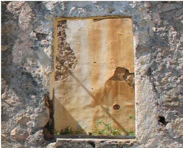
Fig. 139 APL Particolare dell'Apertura con Architravi Lapidiei e Lignei. Sotto l'intonaco si intravede l'architrave lapideo su stipiti ammorsati. Finestra su fronte anteriore, Ed.2, prospetto esterno.
