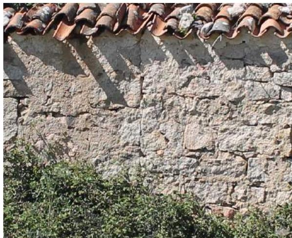
Fig. 40 < F5 Particolare della connessione tra i muri contigui dei due vani non ammassati ma semplicemente affiancati visibile all'esterno sul fronte anteriore. Foto dell'autore.
