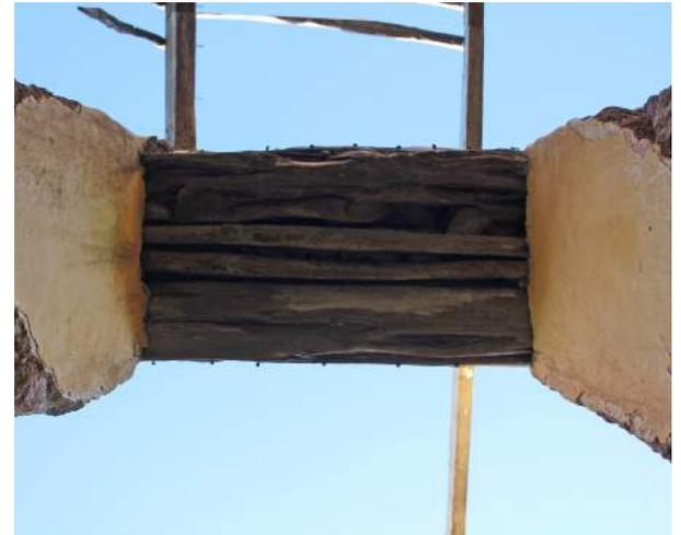
Fig. 131 AL Particolare dell'Apertura con Architravi Lignei. Si nota la successione degli architravi nello spessore. Porta interna, Edificio 2, vista dell'intradosso del vano. Foto dell'Autore.
