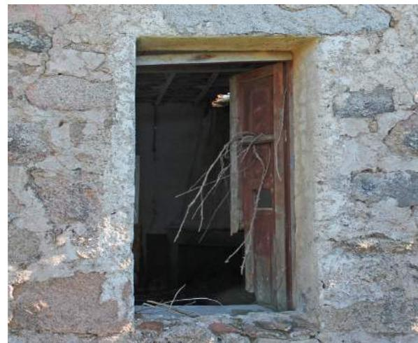
Fig. 63 < F11 Prospetto esterno della finestra dell'*appusèntu* con architrave lapideo, stipiti ammorsati e resti dell'infisso ligneo con traverse e scuretti. Foto dell'autore.
