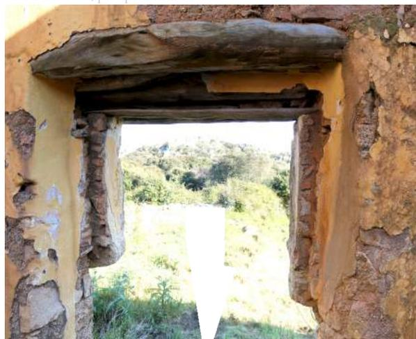
Fig. 133 ALS Particolare dell'Apertura con Architravi Lignei e Triangolo di scarico. Si notano l'architrave ligneo su stipiti ammosati e la strombatura. Porta esterna centrale, Ed.2, prosp. interno
