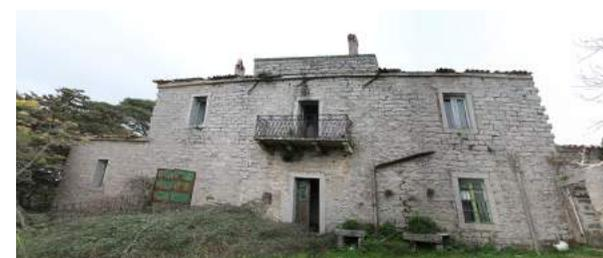
Fig. 24 Stazzo a Palazzu, ottenuto per sopraelevazione del nucleo originario. Stazzo Scarracciàna, loc. Scarracciàna, Tempio Pausania (OT). Foto dell'autore.
