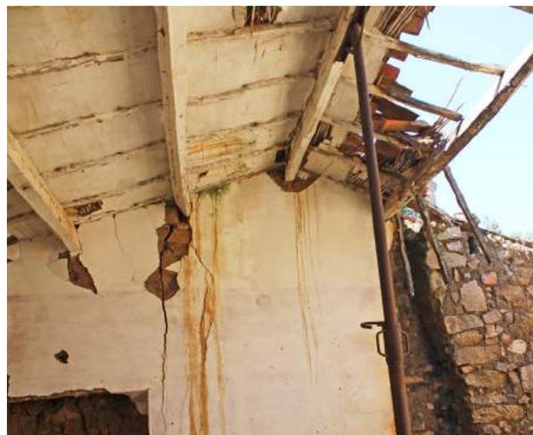
**Fig. 159** OD2 Copertura ad Orditura Doppia con una trave di colmo e 4 arcarecci. Edificio 4, vista dell'intradosso. Foto dell'autore.
