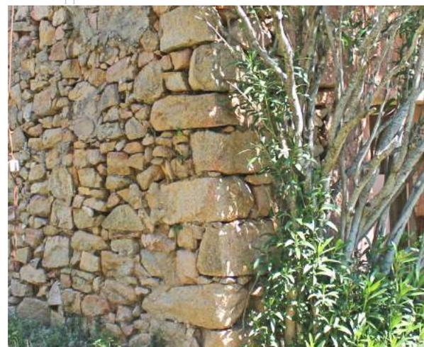
**Fig. 111** < F16 Vista sul cantonale tra il muro anteriore e quello a sinistra, realizzato con conci grandi e ammorsati al coltrario del resto della muratura. Foto dell'Autore.
