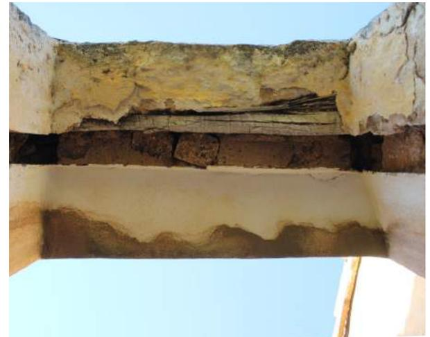
Fig. 141 APL Particolare dell'Apertura con Architravi Lapidiei e Lignei. Sotto l'intonaco, la successione degli architravi nello spessore. Finestra su fronte anteriore, Ed.2, vista intradosso del vano.
