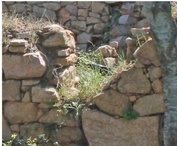
Fig. 84 < F11 Vista dall'esterno sul crollo della muratura del fronte posteriore. Foto dell'Autore.
