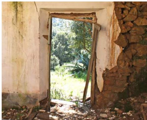
Fig. 100 < F5 Vista del prospetto interno della porta in cui si nota la strombatura e i resti dell'infisso ligneo. Foto dell'Autore.
