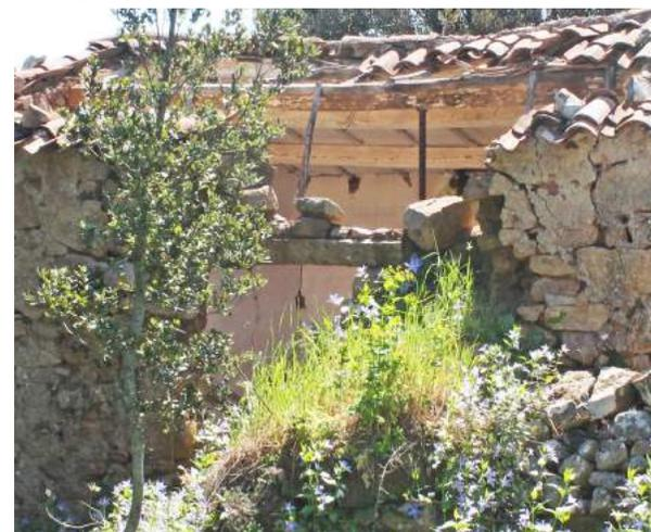
Fig. 105 < F10 Vista sul fronte posteriore in cui è possibile vedere l'architrave della finestra e il crollo della muratura e della falda. Foto dell'Autore.
