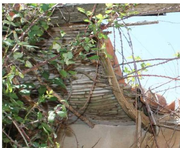
**Fig. 161** IC2 Copertura con Impalcato in Canne parallele con canna maestra. Edificio 1, *casa manna*, vista dell'intradosso. Foto dell'autore.
