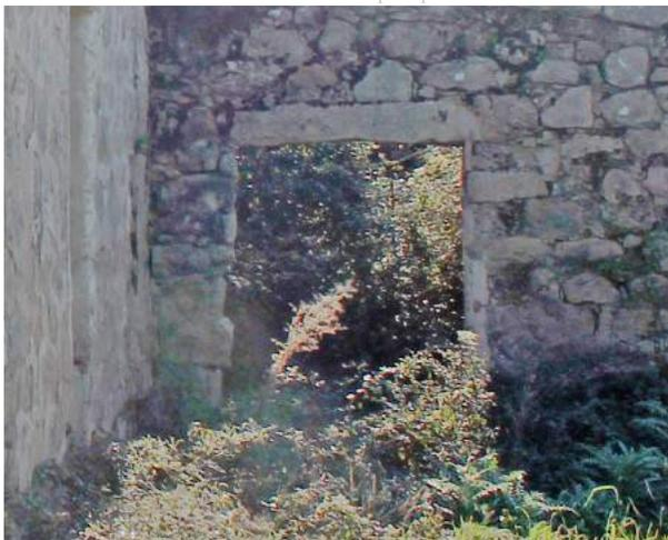
Fig. 145 AP Particolare dell'Apertura con Architravi Lapidiei. Si nota l'architrave poggiante su stipiti ammorsati senza strombatura. Porta esterna del *pinnènti*, Edificio 2, prospetto esterno.
