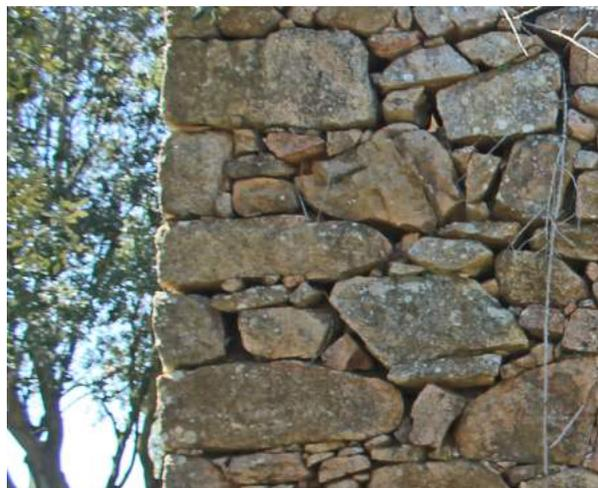
Fig. 86 < F13 Particolare del cantonale ammorsato con conci alternati a mo' di diatoni e ortostati sullo spigolo sinistro del fronte destro. Foto dell'autore.
