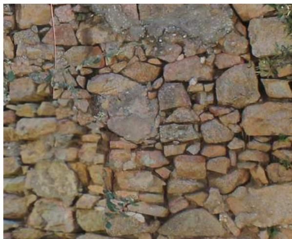
**Fig. 110** < F15 Particolare della muratura in pietra grezza con conci dalle dimensioni prevalentemente medio piccole (MG2i) rilevabile sul prospetto laterale sinistro. Foto dell'Autore.
