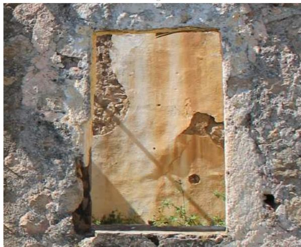
Fig. 62 < F10 Prospetto esterno della finestra del nucleo originario del tipo con architrave esterno lapideo e interni lignei, con stipiti ammorsati e soglia monolitica. Foto dell'Autore.
