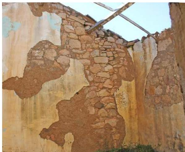
Fig. 54 < F2 Vista dall'interno della *càmbara* in cui si può vedere la muratura con i differenti strati di intonaco e ciò che rimane della copertura. Foto dell'autore.
