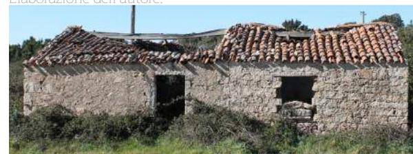
Fig. 4 Stazzo bicellulare nella variante derivata da quello monocellulare. Complesso di Stazzi L'Albitu, loc. Albitu, Aglientu (OT). Foto fril'autore
