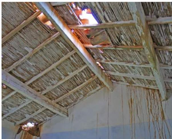
**Fig. 158** OD1 Copertura ad Orditura Doppia con una trave di colmo e 2 arcarecci. Edificio 1, *càmbara*, vista dell'intradosso. Foto dell'autore.
