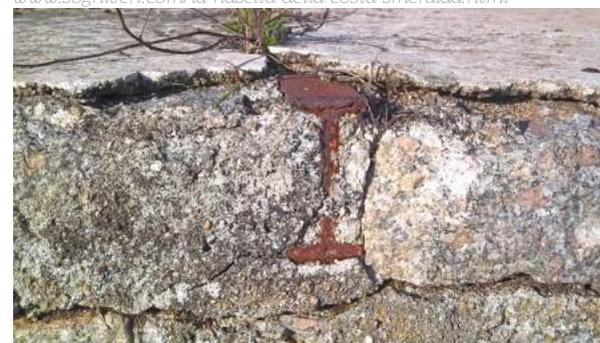
Fig. 33 Particolare dell’inserimento di nuovi materiali nella muratura storica, come travi metalliche per la realizzazione di solai. Stazzo *Mulaglia*, loc. *Mulaglia*, Tempio Pausania (OT). Foto dell’autore
