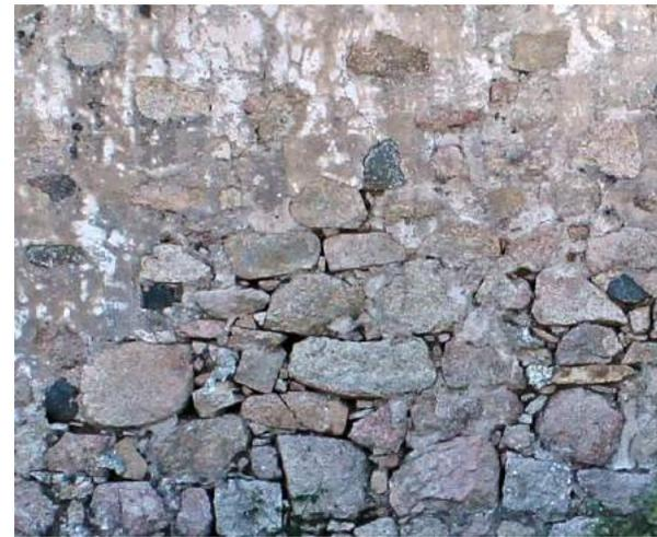
Fig. 119 MG1i Particolare della muratura in pietra grezza con conci di pezzatura prevalentemente medio-grande e intonaco sul fronte destro dell'Edificio 2. Foto dell'Autore.
