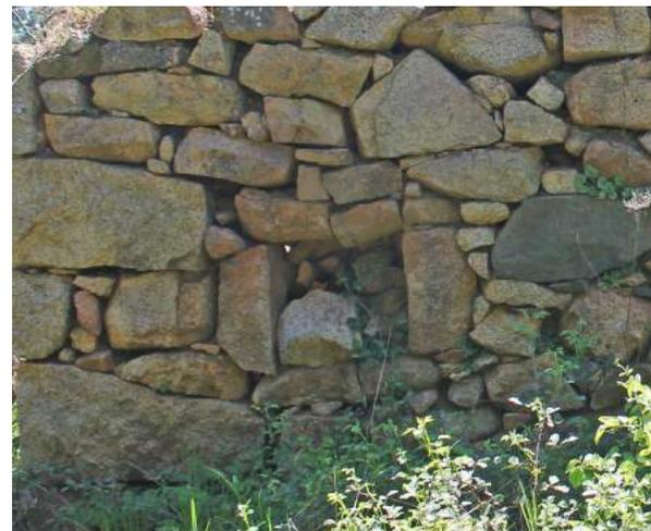
Fig. 83 < F10 Vista sulla porzione di muratura del fronte posteriore con la traccia dell'ipotetica imboccatura del forno. Foto dell'autore.
