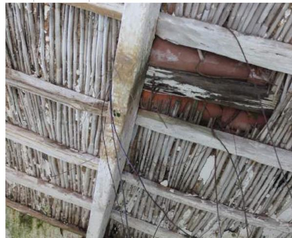
Fig. 42 < F8 Particolare dell'intradosso della copertura sulla *càmbara*. Al centro l'arcareccio a sezione rettangolare, i travicelli a sezione pseudo circolare e l'impalcato in canne. Foto dell'autore.
