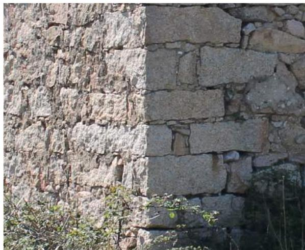
Fig. 45 < F11 Vista del cantonale del vano a destra, realizzato con pietre sommariamente sbazzate e di dimensioni regolari rispetto a quelle con cui è realizzata la muratura. Foto dell'autore.
