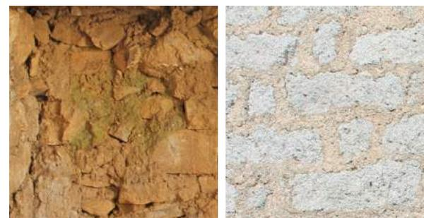
Fig. 20 A sinistra malta di fango usata in abbondanza su una muratura ad opera incerta, a destra malta di terra e calce su muratura pseudo-isodoma. Foto dell'autore.
