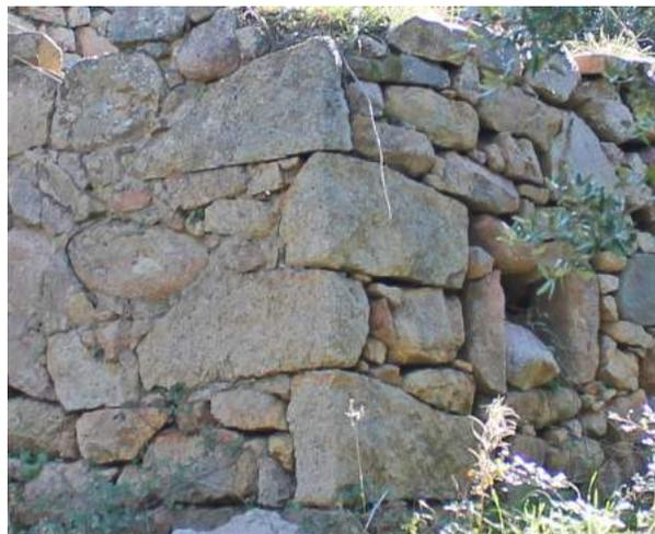
Fig. 82 < F9 Vista sul cantonale tra il fronte posteriore e quello destro, realizzato con conci più grande e regolare alternati per garantire un buon ammassamento. Foto dell'Autore.
