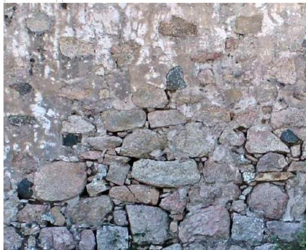
Fig. 66 < F14 Particolare della muratura dell'*appusèntu* del tipo in Pietra Grezza con conci di pezzatura prevalentemente medio-grande e intonaco. Foto dell'Autore.
