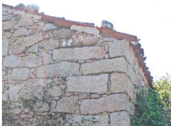
Fig. 47 < F13 Soluzione di gronda con aggetto semplice dei coppi canale sul prospetto laterale destro. Foto dell'autore.
