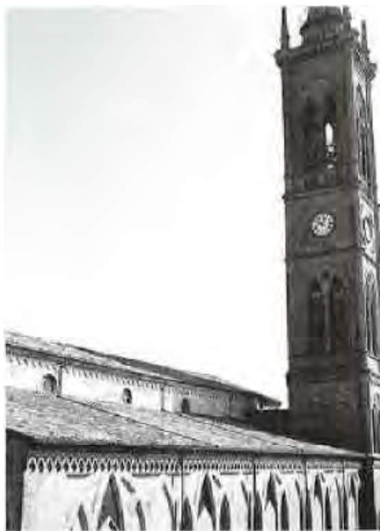
Figura 3.9: Il campanile di Fubine.
