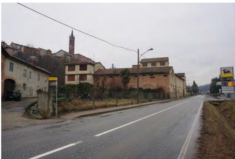
Figura 5.44: La vista della facciata dalla strada Statale 4
