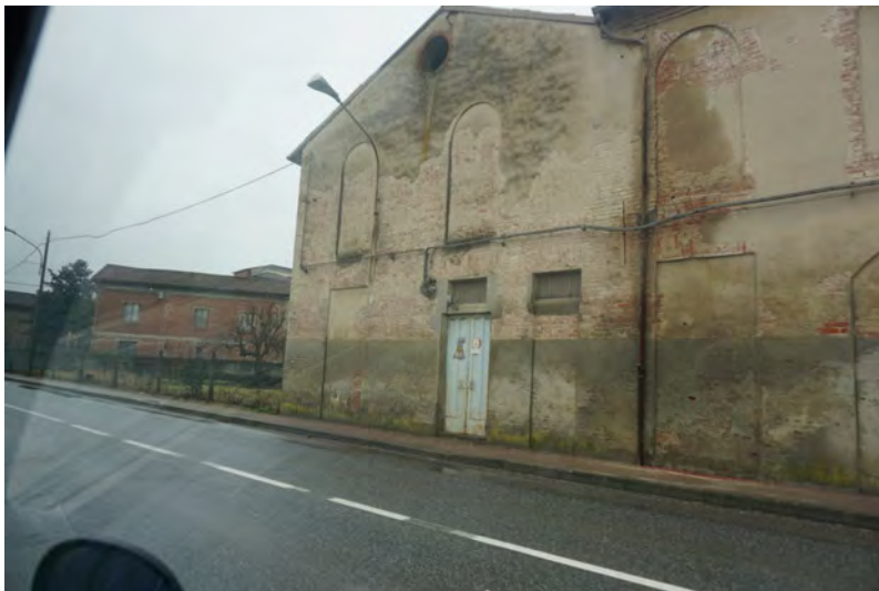
Figura 5.42: La vista della facciata dalla strada Statale 2
