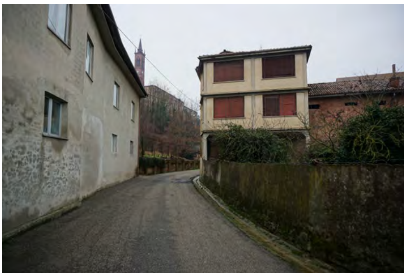
Figura 5.43: La vista della facciata dalla via Balestrero
