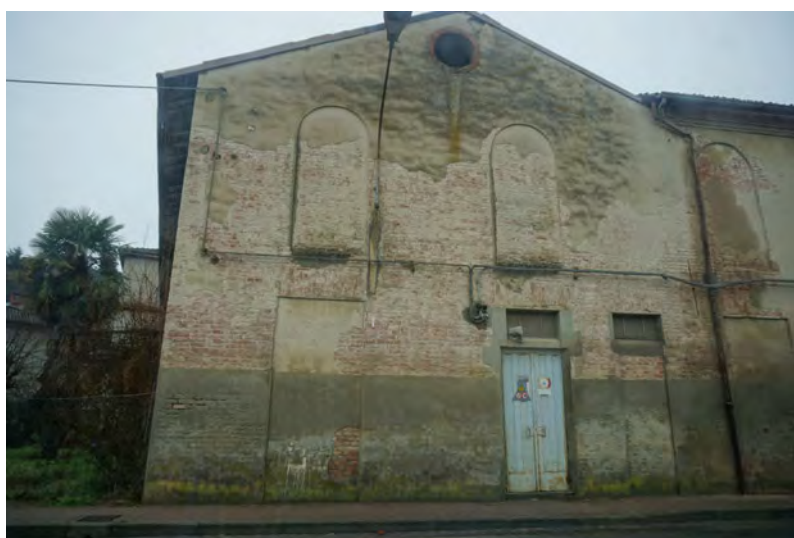
Figura 5.41: La vista della facciata dalla strada Statale 1
