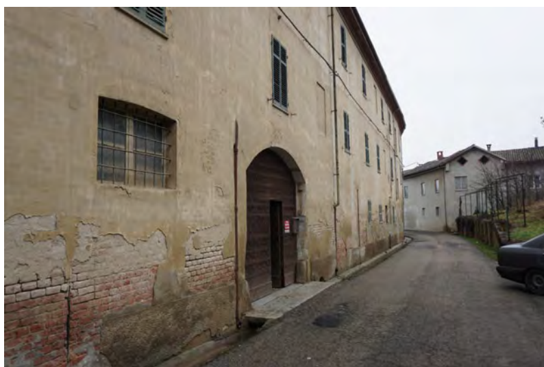
Figura 5.40: La vista della facciata dalla via Balestrero
