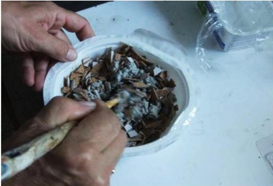
Figura 18 - Tecnica “coccio pesto” con aggiunta di grani di sughero e colla.
