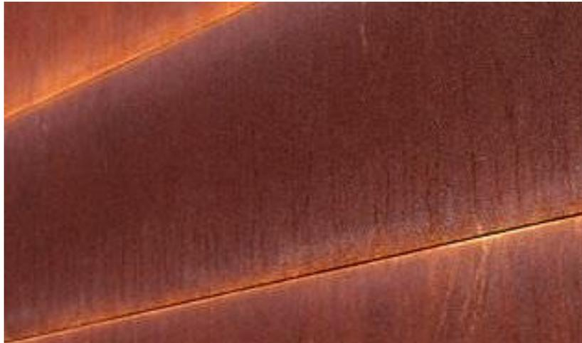
Figura 6 – Rivestimento in acciaio Corten. (fonte: archiexpo.it)
