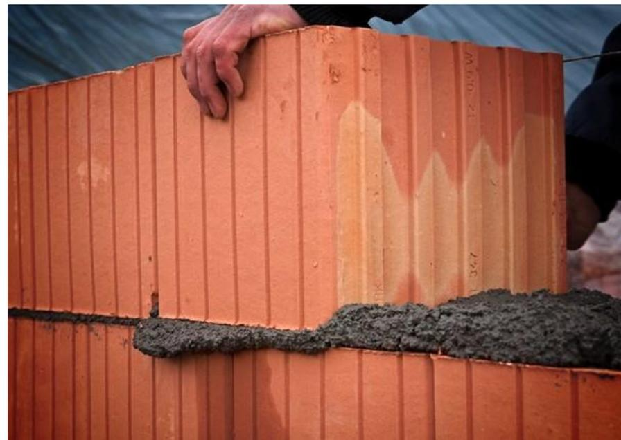
Figura 55 – Blocchi in laterizio previamente bagnati vengono solidarizzati con uno strato legante in malta cementizia. (fonte: genitronsviluppo.com).
