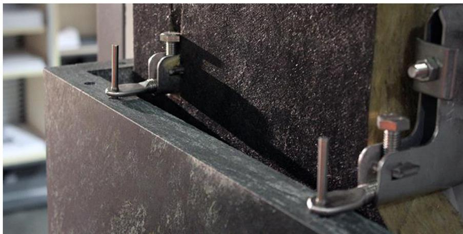
Figura 59 – Dettaglio di sistema di fissaggio puntuale. (Fonte: facade-lab.com).
