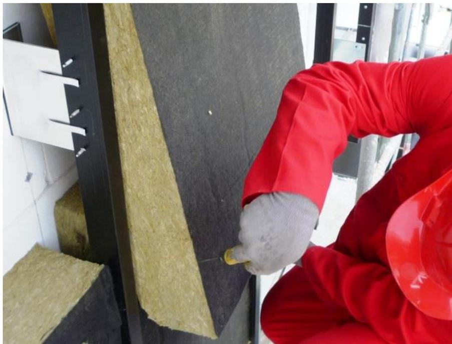
Figura 63 – Posa in opera di pannelli isolanti per facciata ventilata (iocostruisco.it).
