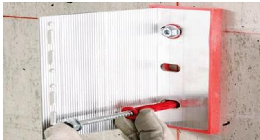
Figura 61 – Installazione di una staffa per l'ancoraggio della sottostruttura allo strato resistente del sistema ([hilti.it](http://hilti.it)).
