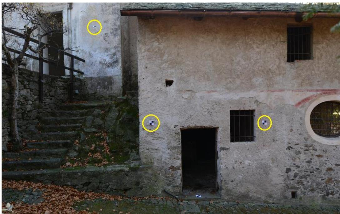
*Figura 21 - Marker per il rilievo topografico e per il rilievo LiDAR
