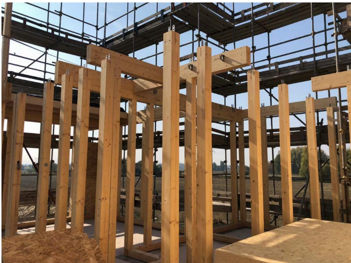
Uno dei principali problemi dei solai in legno è la deformazione, in questo caso per tutta una serie di problemi tecnologici, si è giunti ad un passo delle travi molto fitto e quindi la trama strutturale è un telaio molto ridondante e quindi decisamente iperstatico.
