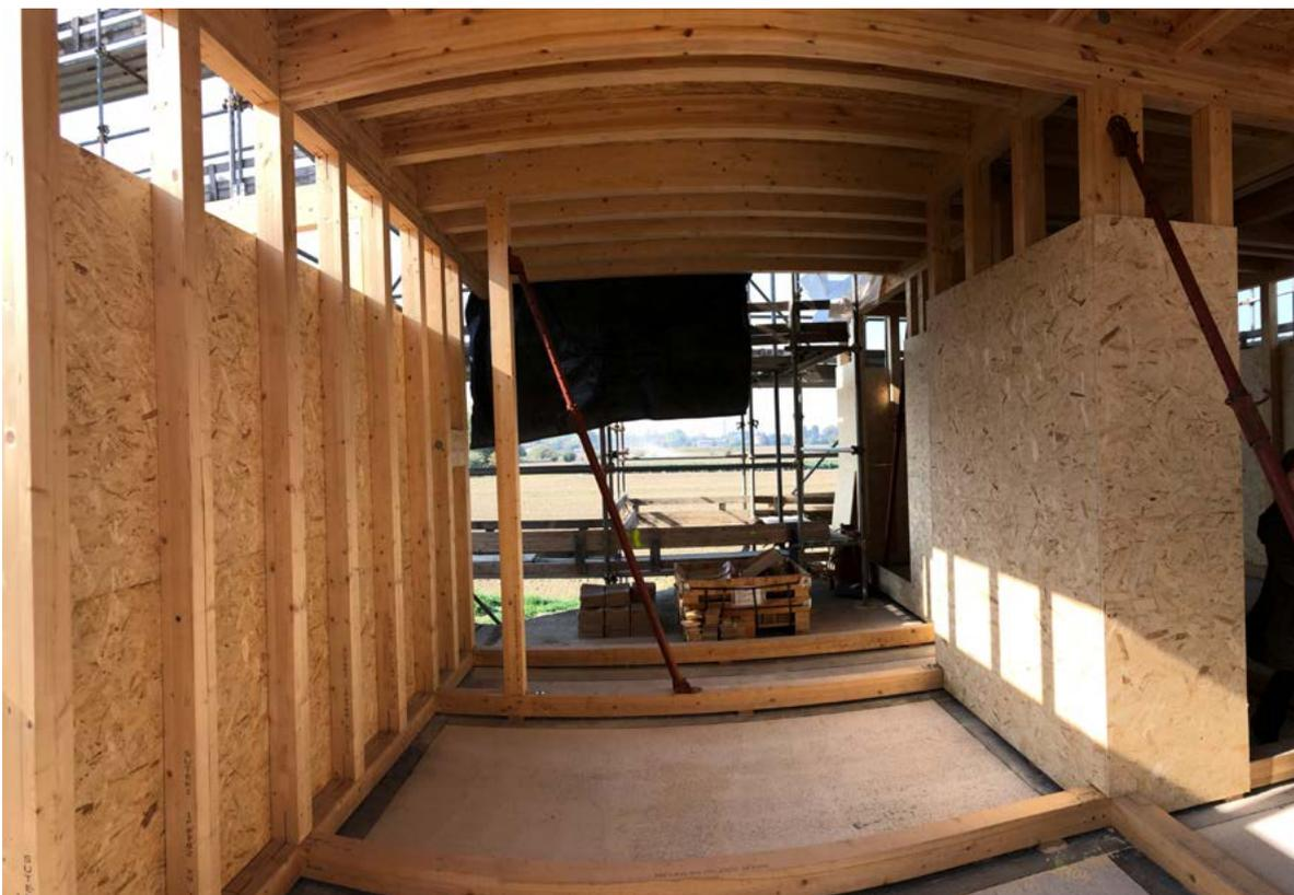
I vantaggi dal punto di vista strutturale di questo sistema, son in primis, l'estrema versatilità. Avendo dei pilastri di sezione piuttosto ridotta, dovranno avere un passo fitto, di base di 1,25m che è esattamente la dimensione di un pannello OSB, a seconda dei casi si possono fare infittimenti o meno. In questo sistema si vanno
