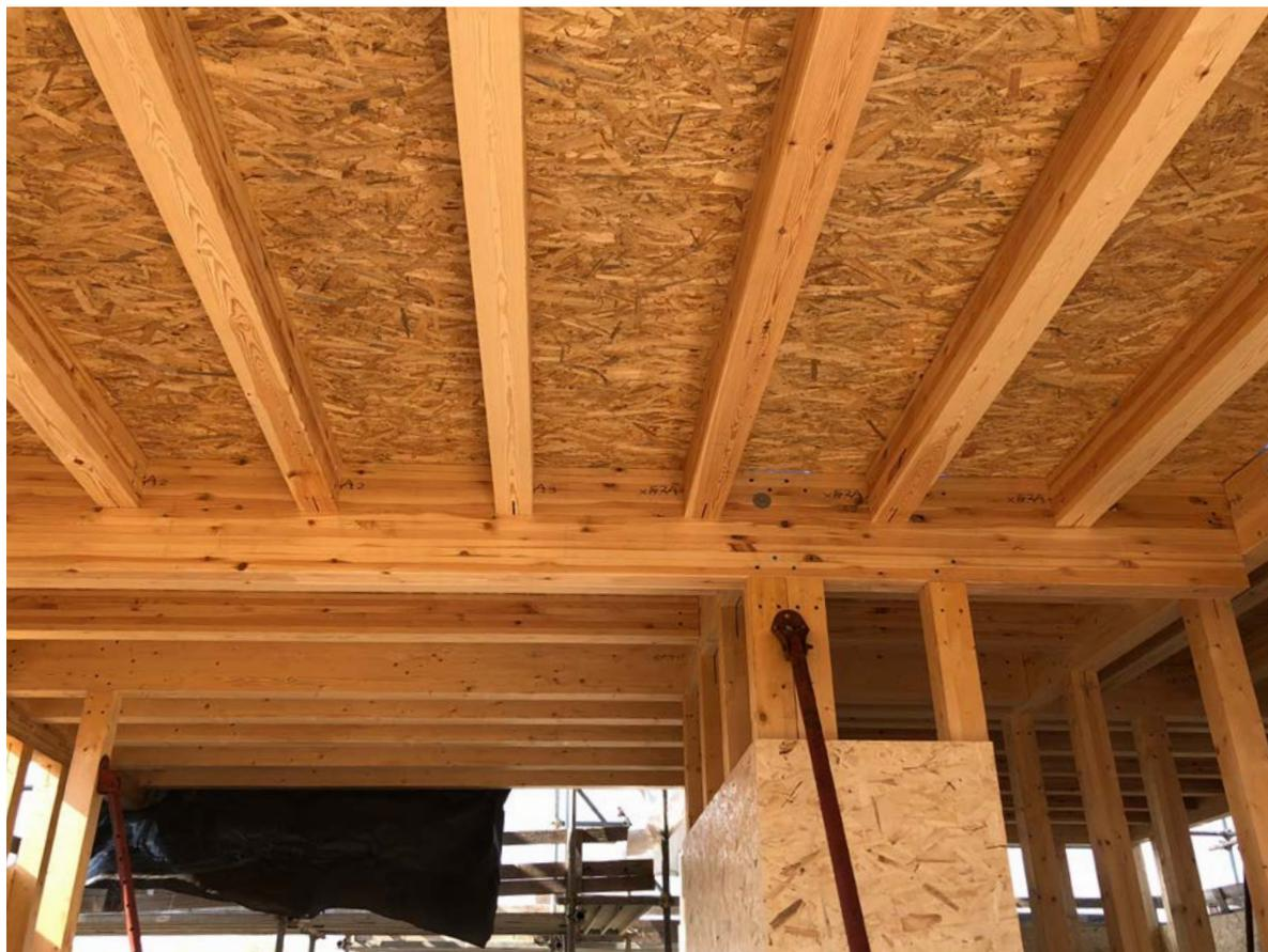
Il Sistema Suteki Wood System, è in possesso di schede di certificazione ECA, un sorta di un'equivalente marcatura CE, per quanto riguarda tutti i nodi di collegamento. La tipologia di legno utilizzata di default è il GL24 classe 2, poi secondo all'esigenza si può modificare secondo la norma UNI 14080.
