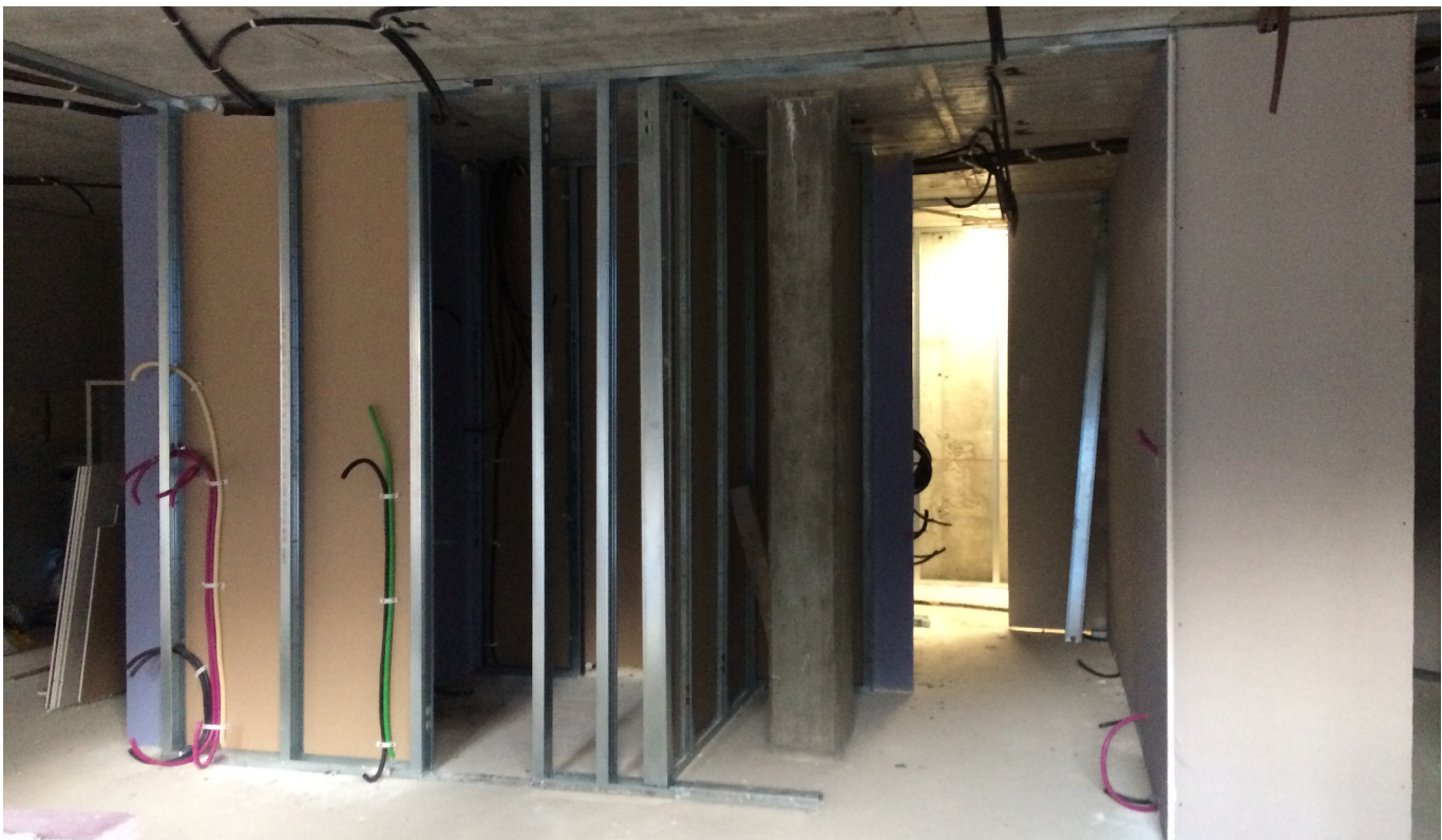
Fig. 8.6, foto di cantiere. Come si nota, sono presenti i montanti esclusi dalla modellazione. Fonte: DVA-Bim Factory
