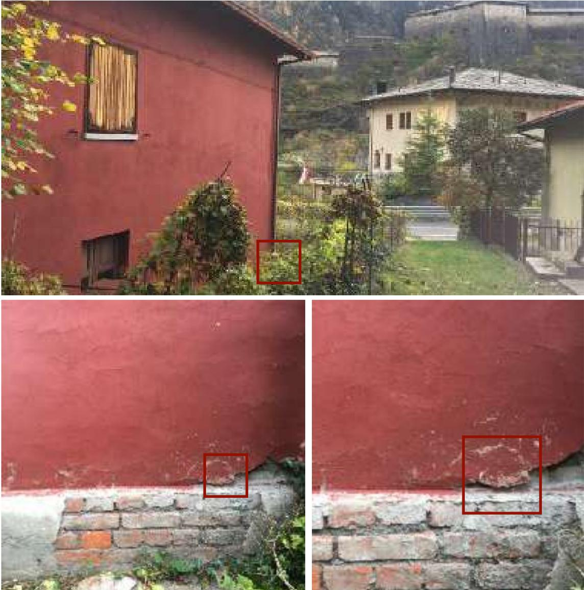
*Fig.71-72-73 Casa Cantoniera di Exilles, dettaglio di porzione del degrado sulla facciata sud ovest. Fotografia del 08/11/2018*
