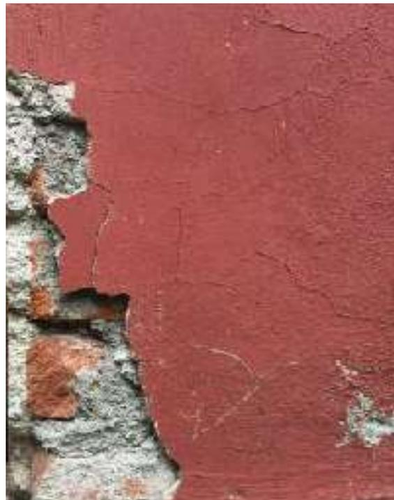
Fig.60 Casa Cantoniera di Exilles, dettaglio di porzione del degrado sulla facciata sud ovest.
