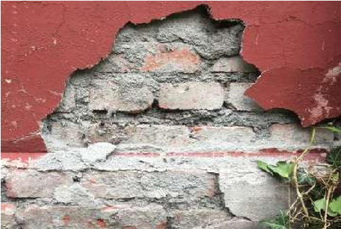
Fig.58 Porzione di facciata sud ovest di Exilles da cui si è distaccato l'intonaco a causa delle infiltrazioni della vegetazione rampicante. Fotografia del 08/11/2018
