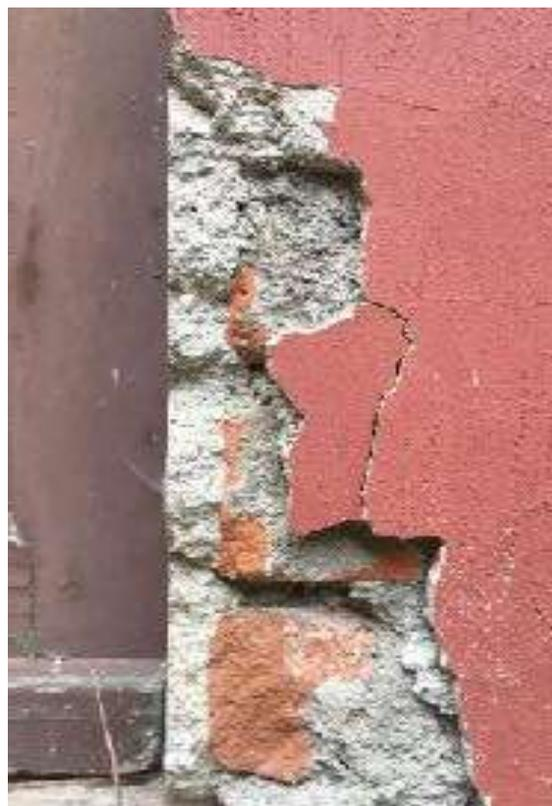
Fig.82 Casa Cantoniera di Exilles, dettaglio di porzione del degrado sulla facciata sud ovest.
