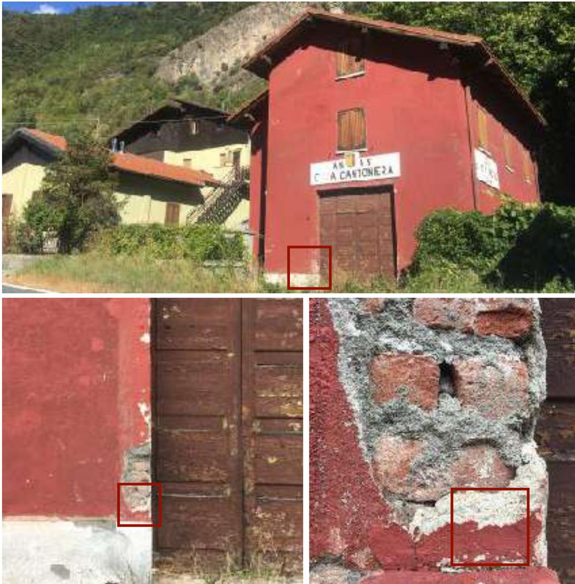
Fig.74-75-76 Casa Cantoniera di Exilles, dettaglio di porzione del degrado sulla facciata sud est. Fotografia del 08/11/2018
