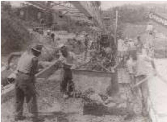
Fig.16 *Cantonieri al lavoro per la costruzione di una strada agli inizi del 1900 in una fotografia tratta dal libro “Il viaggio dell’Anas 1928-2008 - Le immagini”, 2008*
