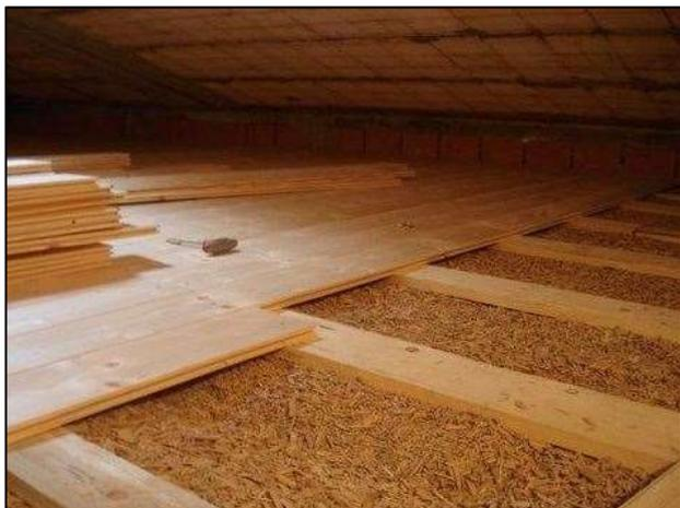
Fig. 5.44 Isolamento di sottotetto
