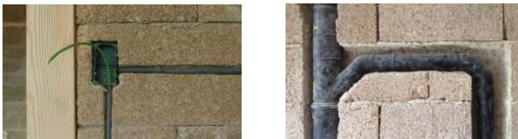
Fig. 2.25 Scanalature per inserimento di scatolette e tubazioni.
