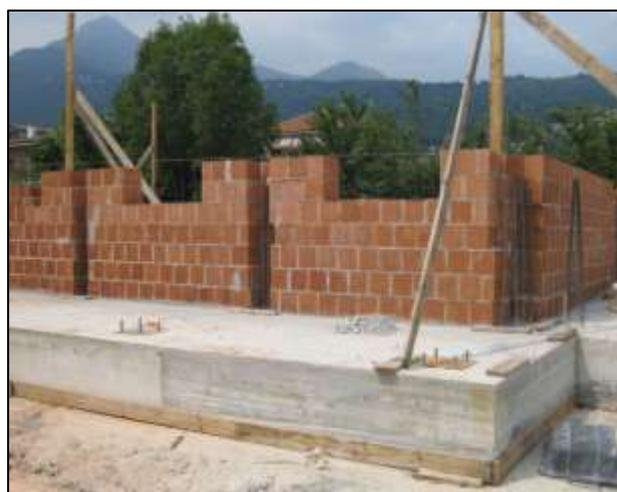
Fig. 4.35 Realizzazione di muri perimetrali con blocchi in laterizio alleggerito e verifica di allineamento.
