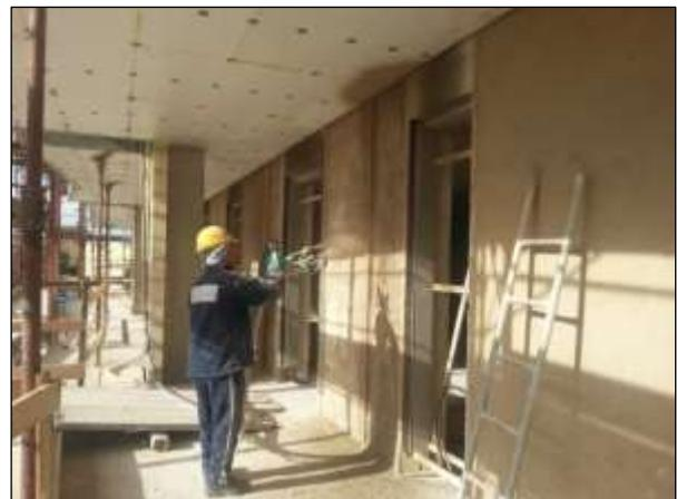
Fig. 2.24 Applicazione della miscela calce canapa con macchinario a spruzzo a Bisceglie, Casa di Luce.
