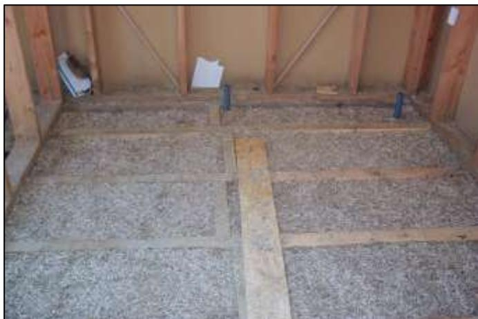
Fig. 5.46 Soletta isolante in canapa e calce
