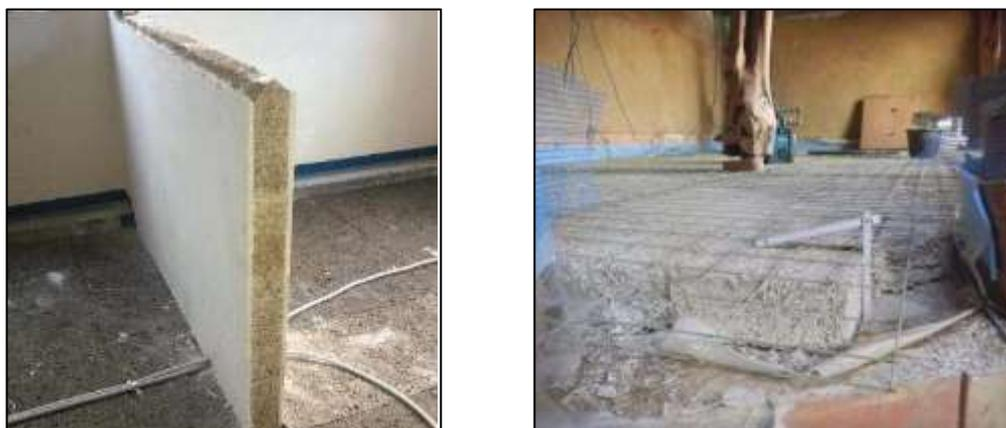
Fig. 1.14 Pannelli in fibra di canapa per realizzazione dell'isolamento di tramezzi interni e di solai.
