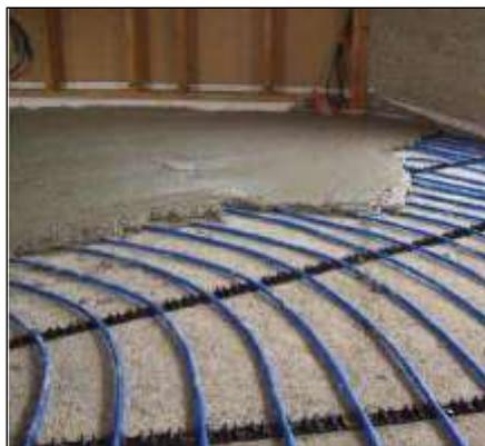
Fig. 2.26 Impianto di riscaldamento a pavimento su massetto in calce e canapa e copertura dell'impianto con massetto in calce e sabbia.
