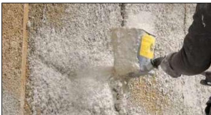
Fig. 15.48 Termointonaco di canapa e calce proiettato sul muro
