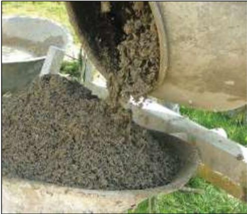
Fig. 2.22 Miscelazione Calce e Canapa con Betoniera classica.
