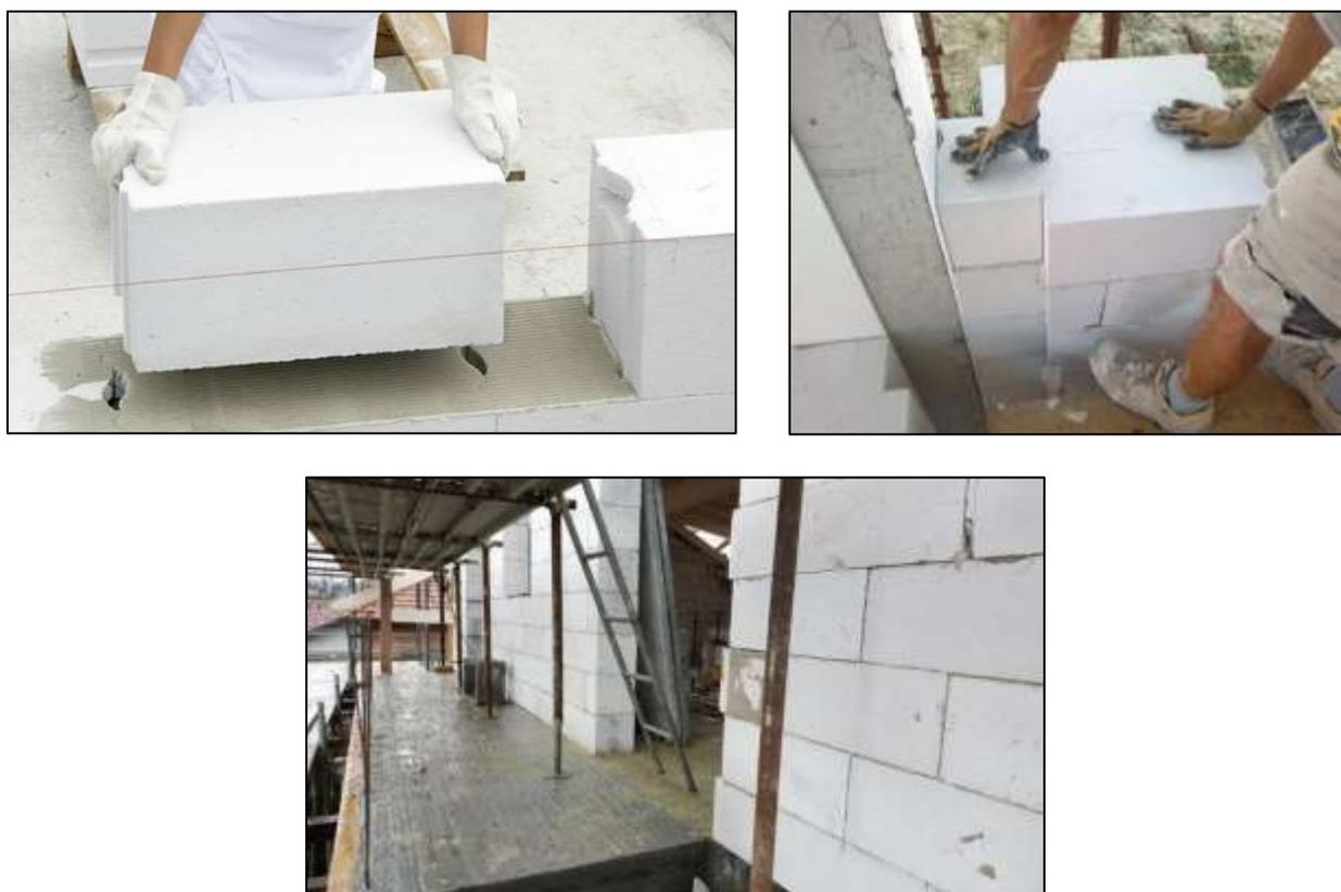
Fig. 4.34 Blocchi in calcestruzzo cellulare dalla posa alla realizzazione di muri.
