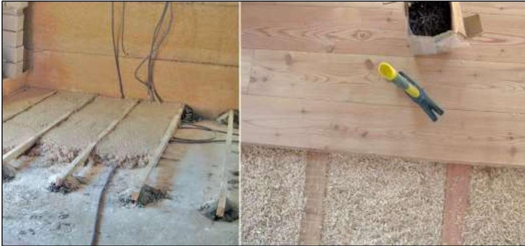
Fig. 1.15 Calce e canapulo per realizzazione di sottofondi.
