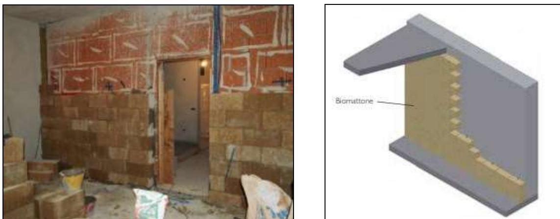
Fig. 5.40 /5.41 Cappotto isolante interno su muratura esistente
