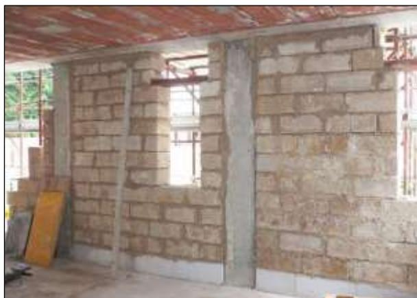
Fig. 5.36 Muratura di tamponamento monoblocco
