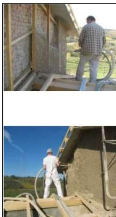
Fig. 5.43 Coibentazione tramite cappotto esterno spruzzato
