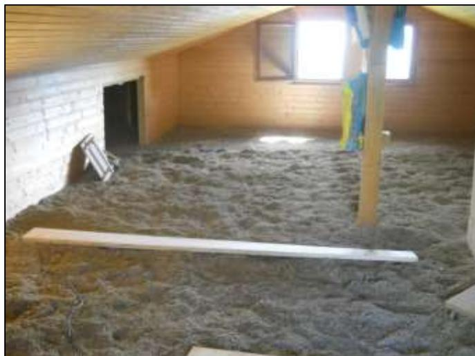
Fig. 5.47 Sottofondo isolante in canapa e calce
