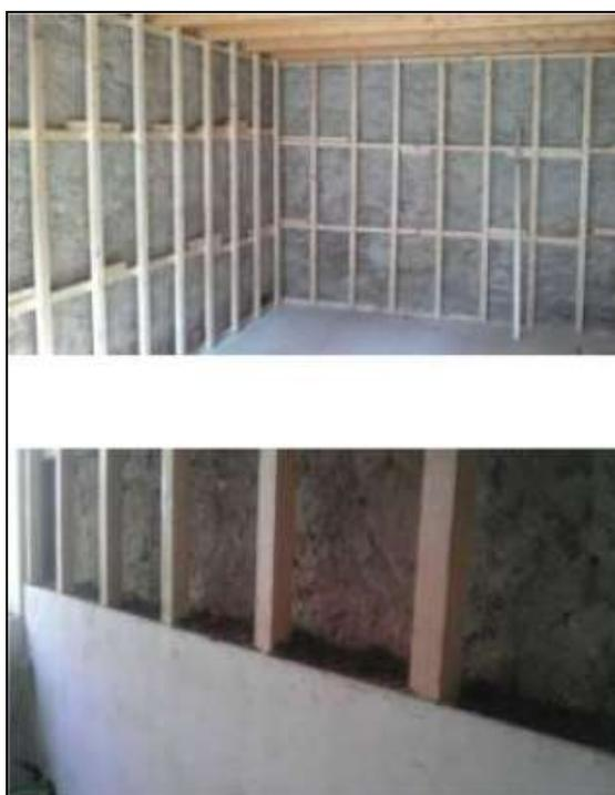
Fig. 5.42 Coibentazione tramite cappotto interno con lastre magnesite
