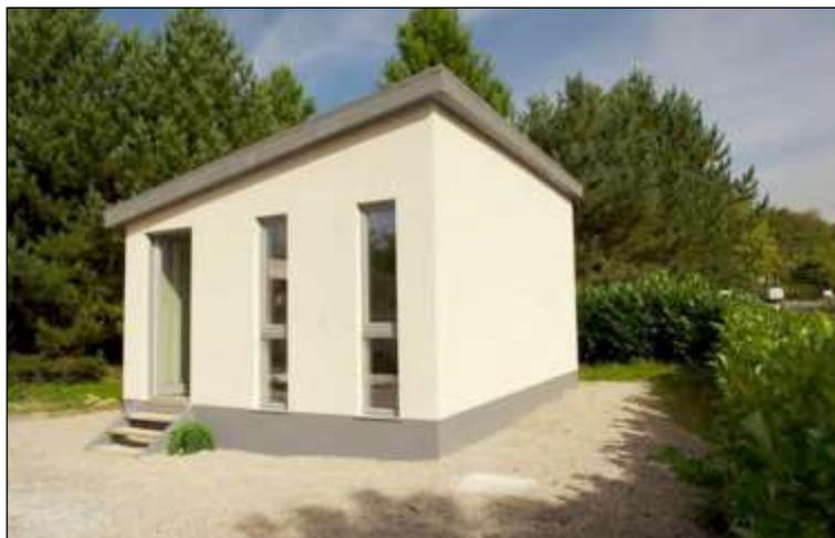
Fig. 2.28 Esperimento con l'edificio in canapa e calce all'università di Bath
