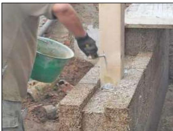
Fig. 4.33 Realizzazione di muri di tamponamento con blocchi in calce e canapa e verifica di allineamento.
