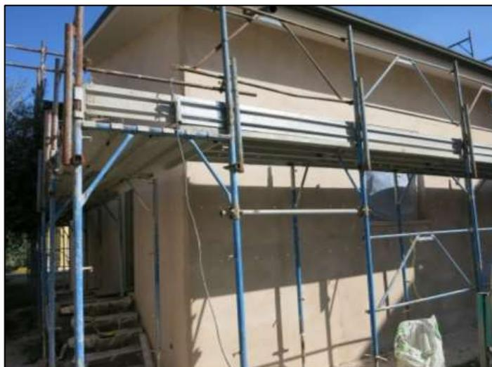
Fig. 5.68 Intonaco esterno in calce
