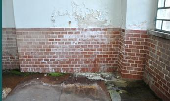
Degrado dovuto alle infiltrazioni d'acqua.
