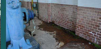
Degrado dovuto alle infiltrazioni d'acqua.
