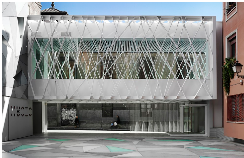
img. 37 - Disegno di progetto dello studio Aranguren e Gallegos del prospetto dell'edificio su calle Amaniël, è evidente il contrasto tra il vecchio e le forme geometriche apportate con l'intervento. img. 38 - Prisma longitudinale che sormonta l'accesso al museo da Calle Amaniël.
