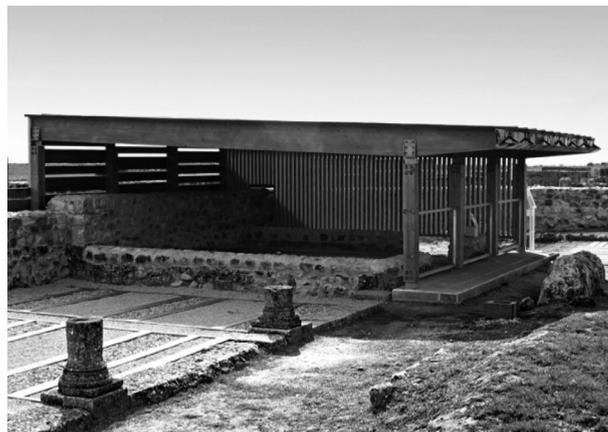
**fig.20** Domus del mosaico dei crateri, Burgos (Spagna). Le lamelle lignee della struttura a protezione del mosaico permettono un'integrazione diretta con la rovina che proteggono.
